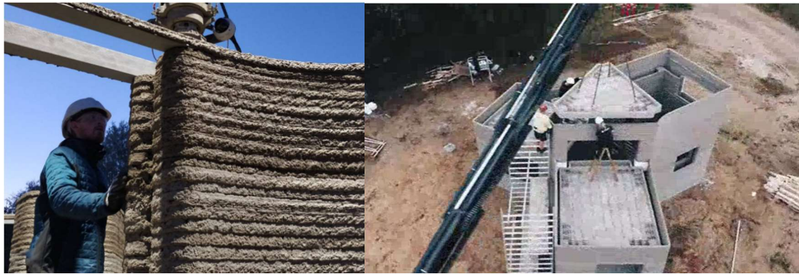
Imagem 66 – Montagem de padieira da porta e janela e montagem de cobertura [91].
