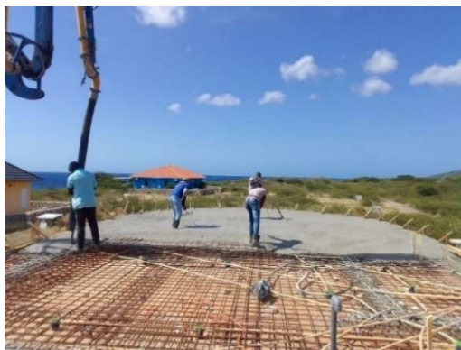
Imagem 55 - Execução da cobertura [79]
