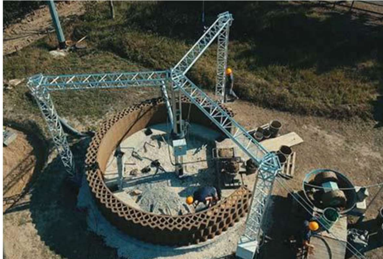
Imagem 45- Processo de execução de obra da casa Gaia e colocação de fibras de arroz [63]
