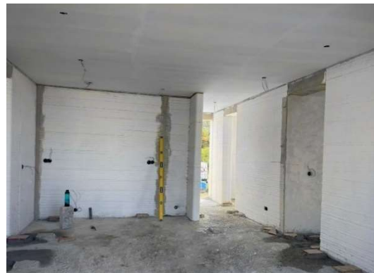
Imagem 56 - Execução de infraestruturas[75]
