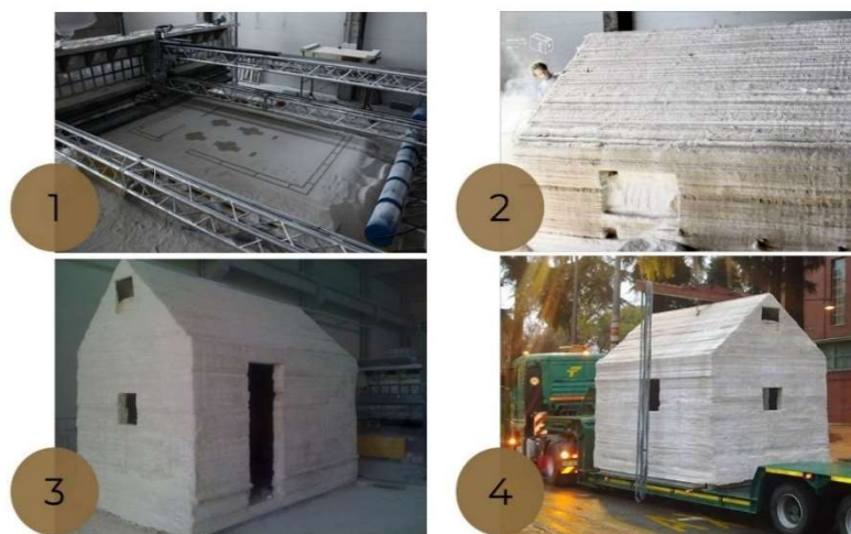
Imagem 14 - The Ferreri House construído usando o método D-Shape [23].
