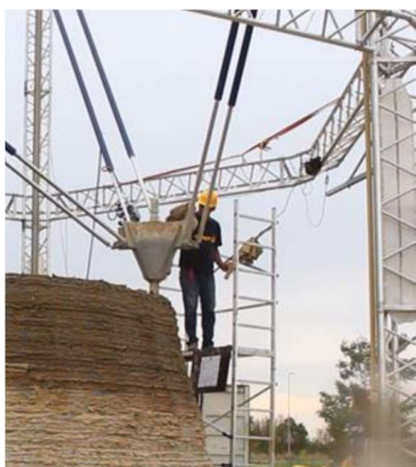
Imagem 31 - Big Delta em ação e técnico fazendo inspeção da impressão
