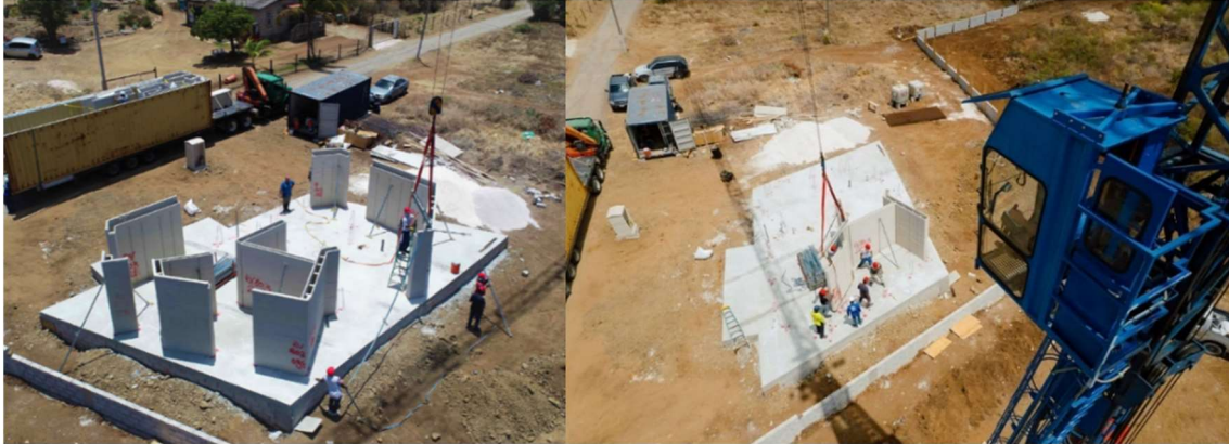
Imagem 54- Assemblagem das paredes com ajuda de uma grua [96].
