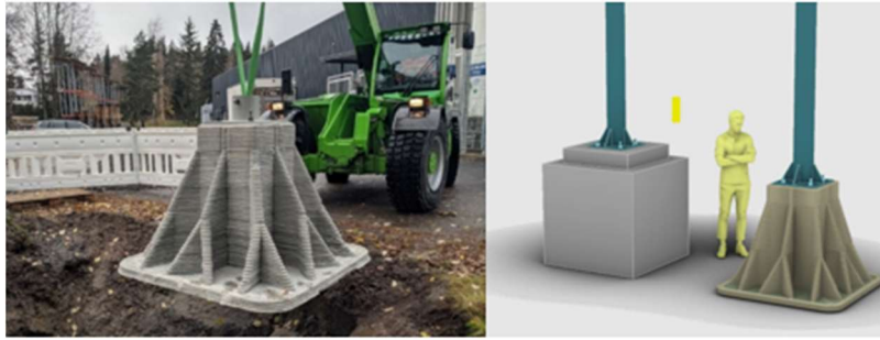
Imagem 22 - Colocação das fundações no local de obra e comparação com sapata usando o método convencional [33]
