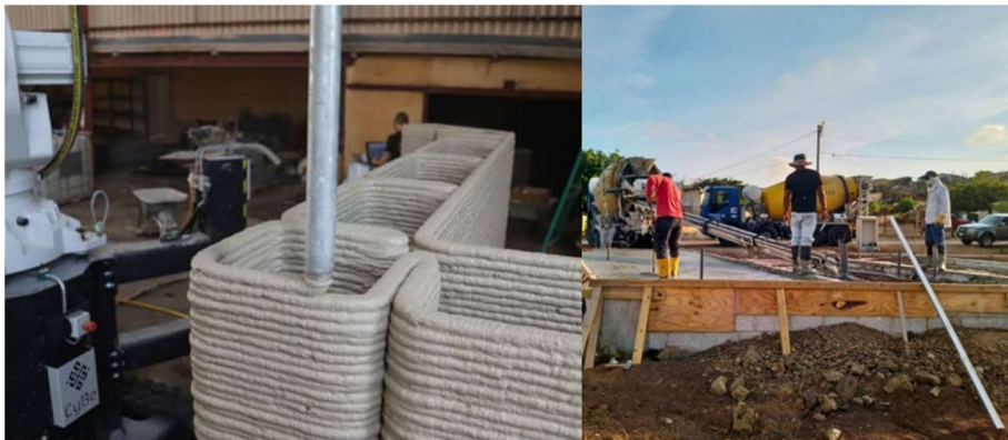
Imagem 53 – Impressão das paredes off-site execução da fundação em tecnologia convencional [78]
