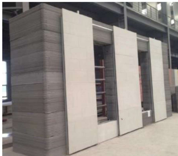
Imagem 12 - Assemblagem de revestimento cerâmico em paredes impressas [21].
