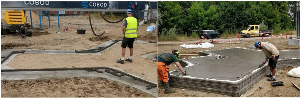
Imagem 64 - Execução de betão de limpeza e laje de pavimento [90]
