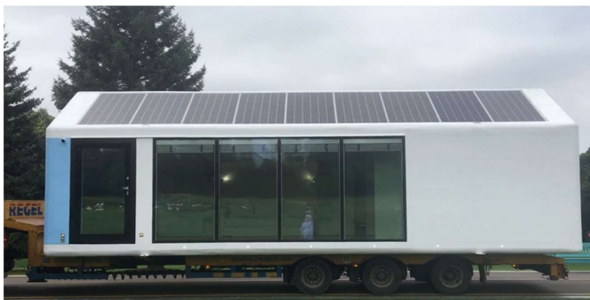
Imagem 20 - Transporte um empreendimento AI SmartHome construído com recurso da 3DPC [30].
