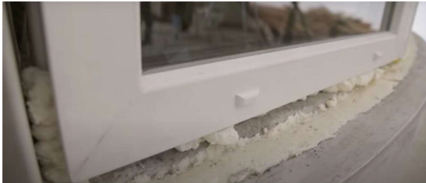
Imagem 62 - Colocação de janelas [86]
