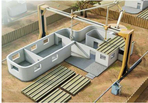
Imagem 25- Imagem ilustrativa da impressão 3DPC in situ [20].
