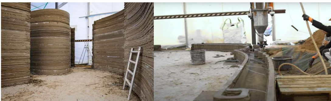
Imagem 40 - Execução da estrutura [65]
