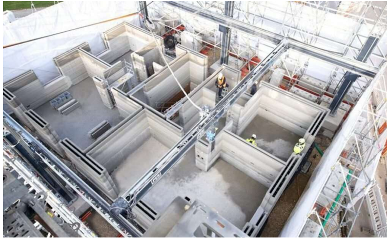
Imagem 11 - Ilustração de um sistema de Contour Crafting em ação [95]
