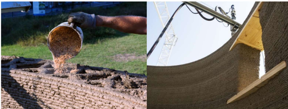
Imagem 51 – Inserção de cascas de arroz nas cavidades das paredes e Construção de vãos com reforço estrutural em pranchas de madeira [71].
