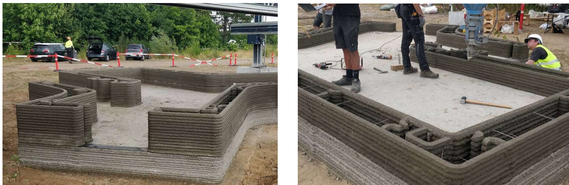
Imagem 65 - Execução das paredes e colocação de armaduras [89].
