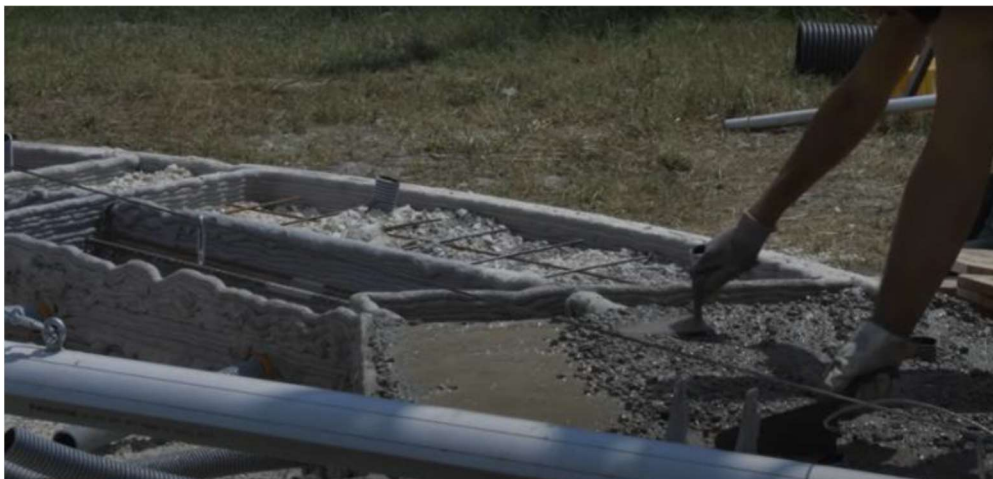
Imagem 47 - Colocação de armaduras junto às fundações – Gaia [72]
