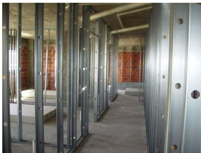
Figura 73 Divisórias em Gesso Cartonado - Fonte: Multi Perfil
