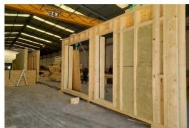
Figura 75 Fachada e Pilares - Fonte: Casais
