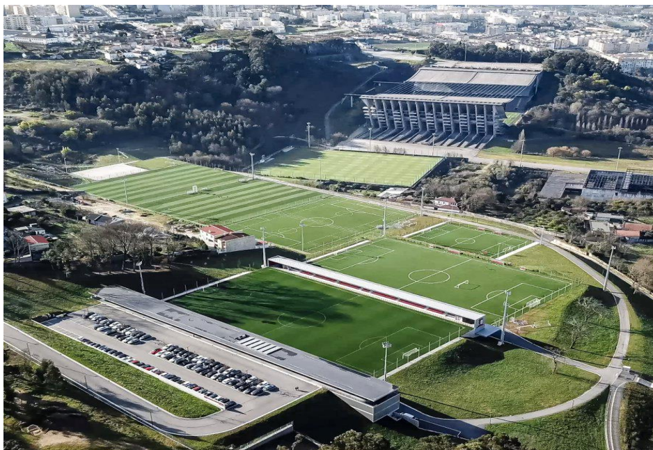
Figura 5: Cidade Desportiva, Imagem aérea.
