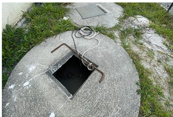
Figura 15 – Tanque 1 e 2 respetivamente.
