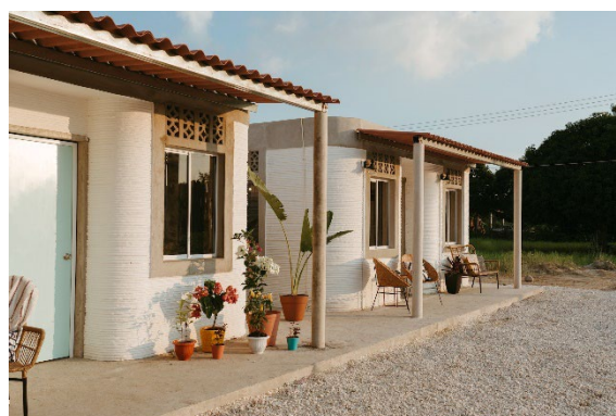
Figura 10 – Casa impressa em Tabasco, Mexico feita pela empresa ICON 3D ( 3D-Printed Homes in Nacajuca, Mexico with New Story – ICON , 2023)
