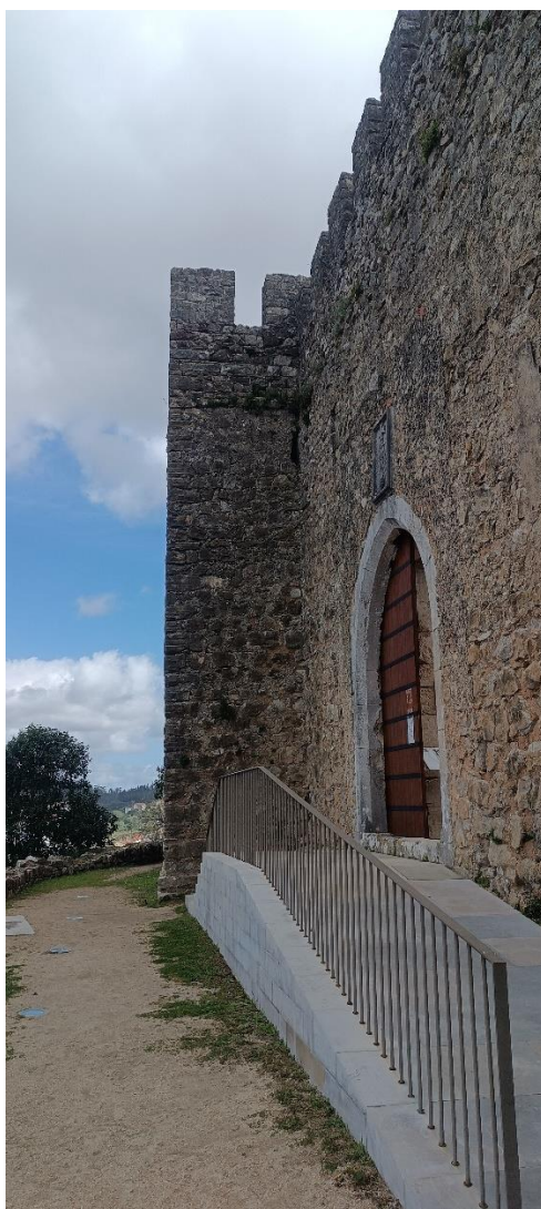
Foto 44 – Torreão F (lado voltado ao pano de muralha 5).
