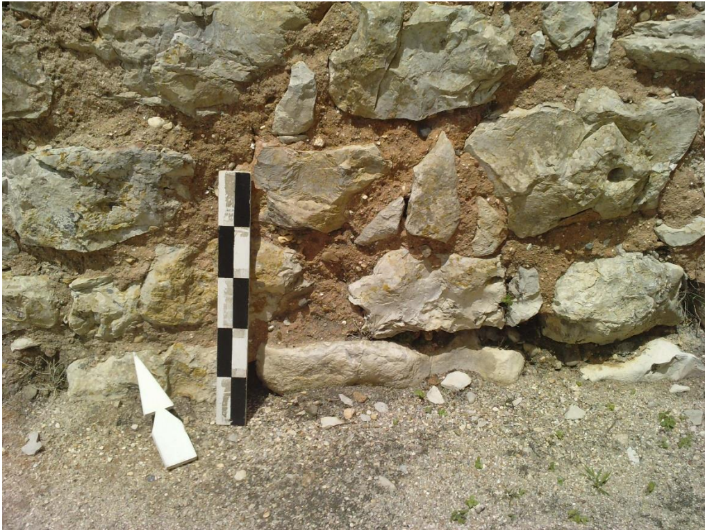
Foto 36 – Pormenor de aparelho do pano de muralha 4.
