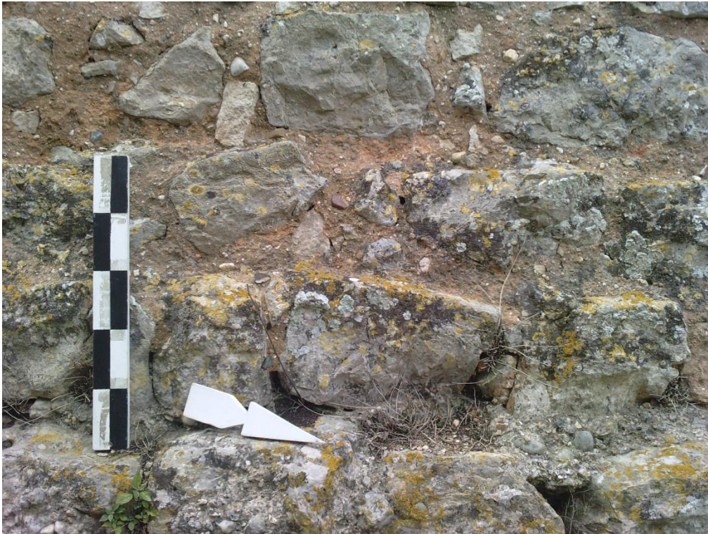
Foto 60 – Pormenor de aparelho no torreão H.
