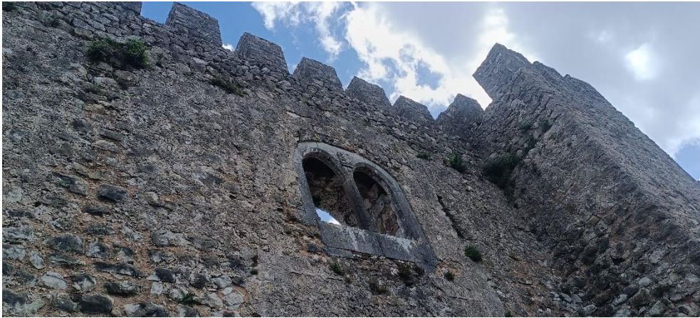
Foto 34 – Janela no pano de muralha 4.
