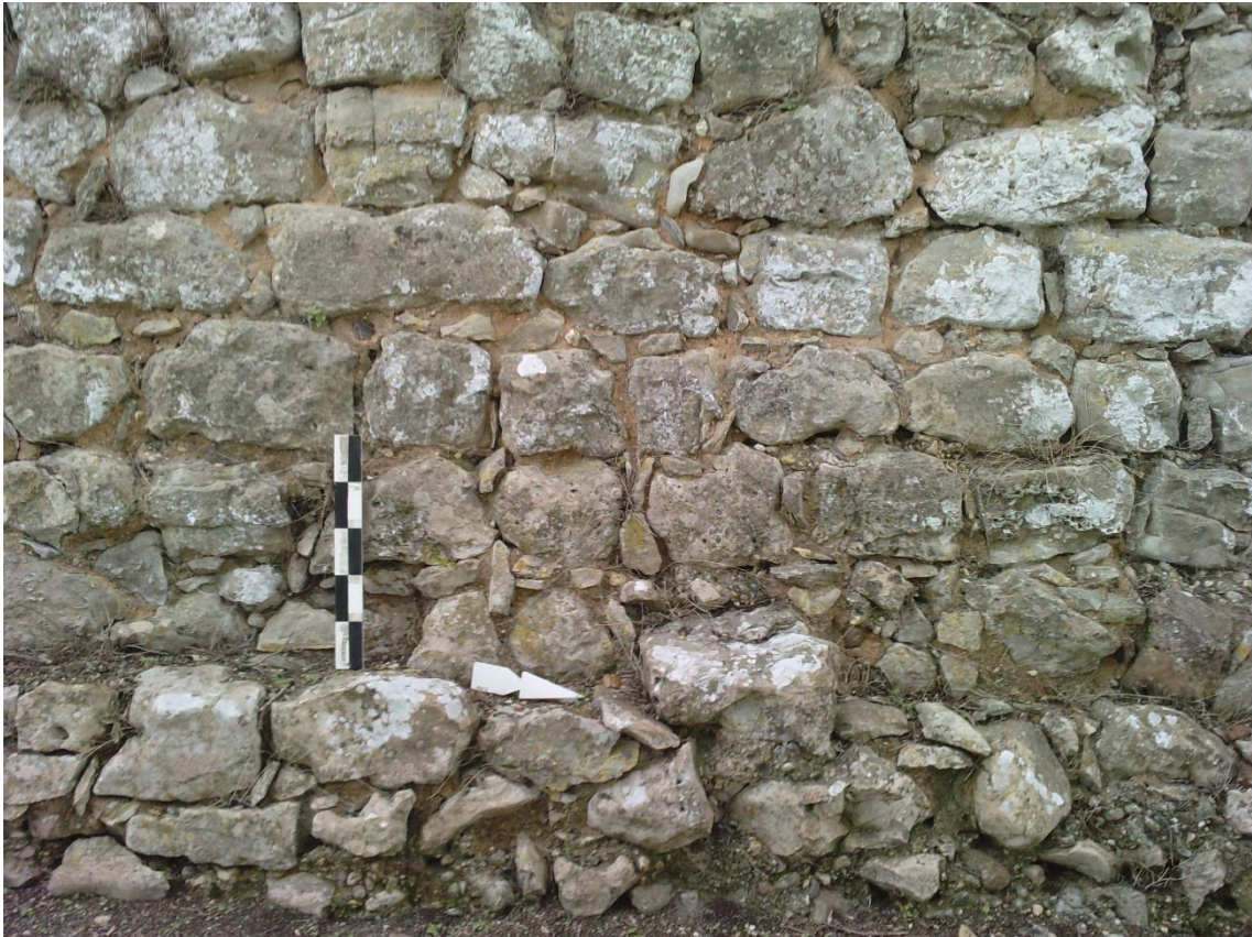
Foto 63 – Pormenor do aparelho do pano de muralha 8.
