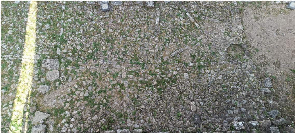
Foto 85 - Pavimento junto à face principal da torre de menagem.
