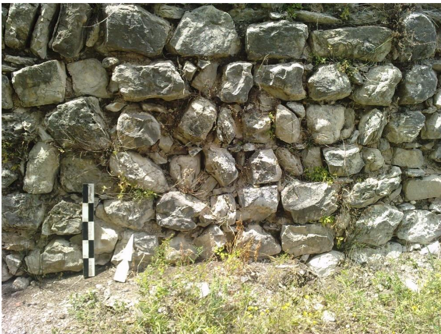
Foto 5 – Pormenor de aparelho no pano de muralha 1.
