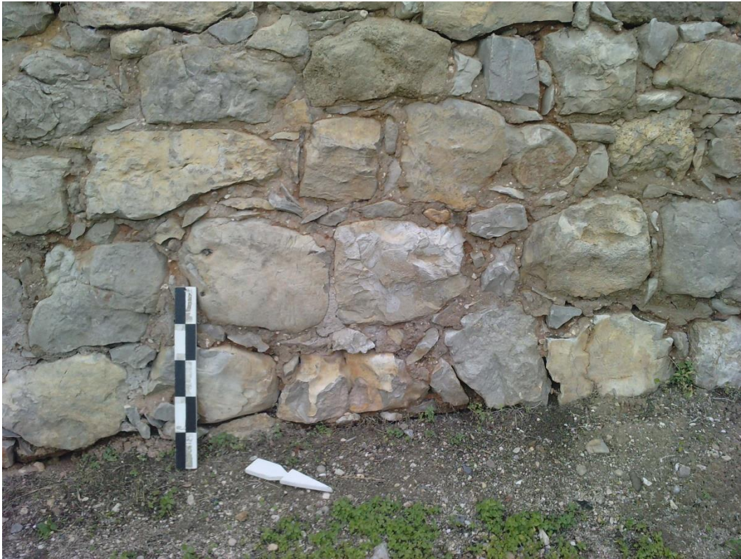
Foto 69 – Pormenor do aparelho do pano de muralha 9.
