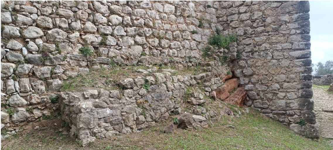
Foto 16 – Alambor no pano de muralha 2.
