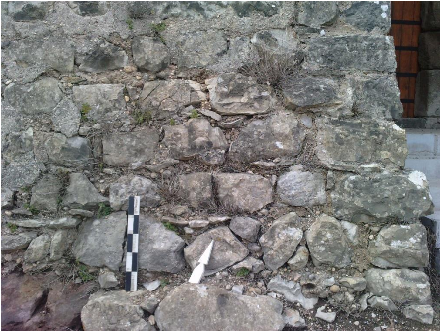
Foto 6 - Pormenor de aparelho no pano de muralha 1/face exterior do torreão A.
