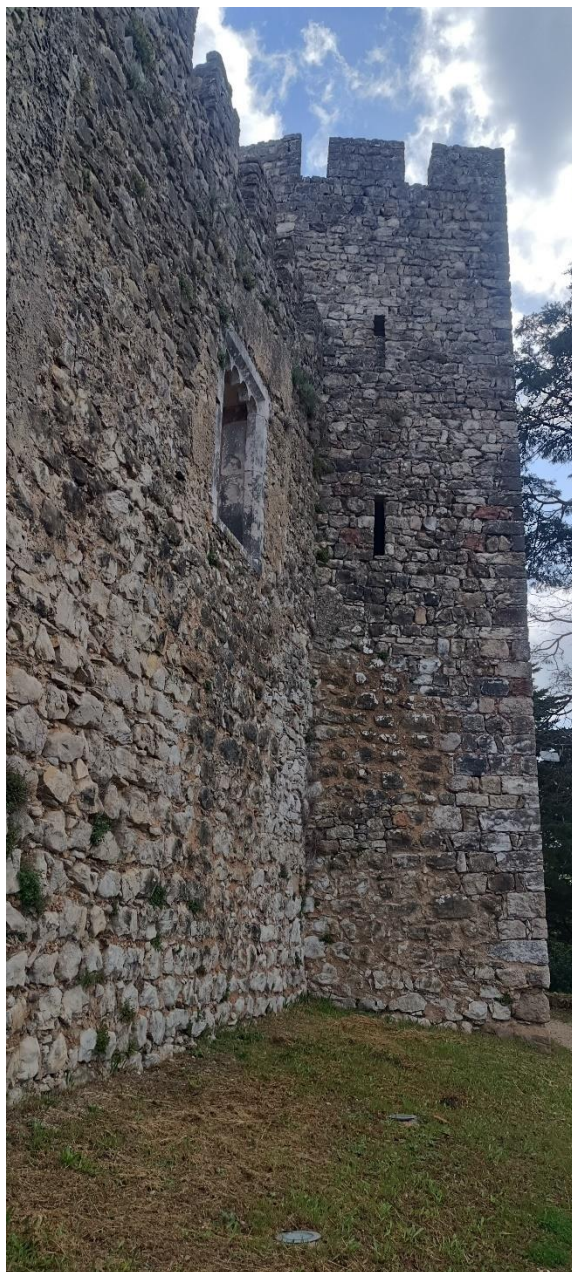
Foto 18 – Torreão C (face voltada para o pano de muralha 3).
