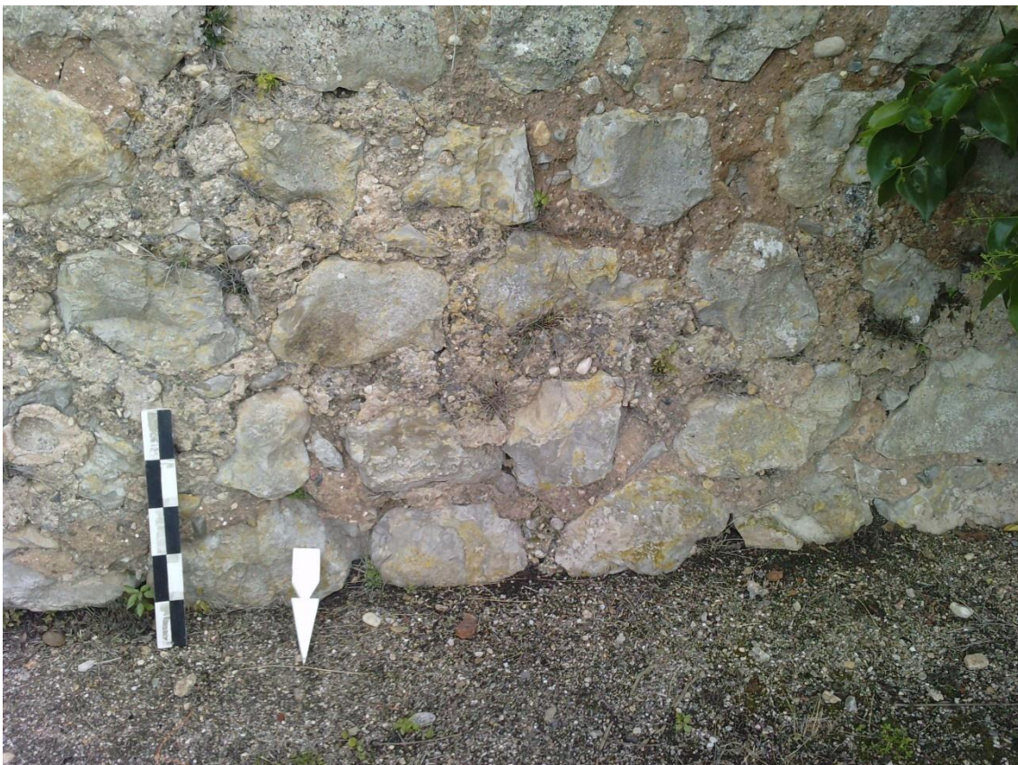
Foto 46 – Pormenor de aparelho no torreão F.
