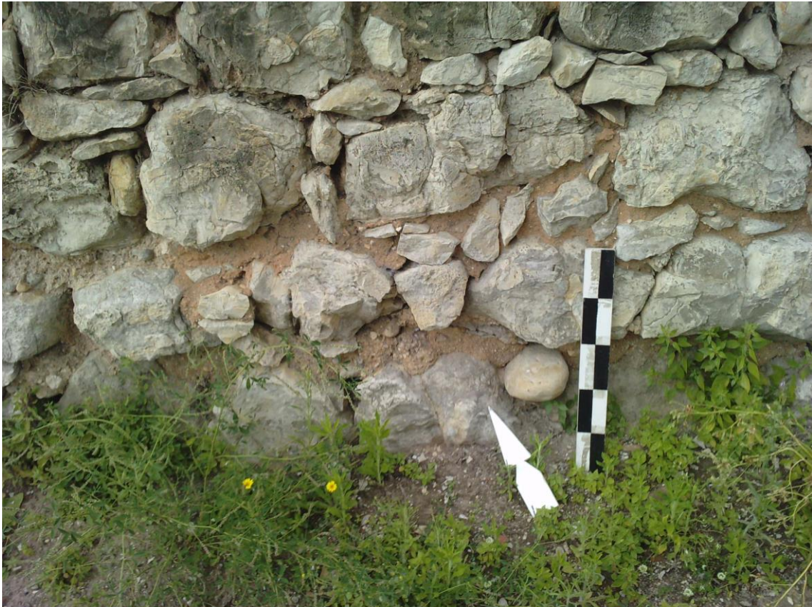
Foto 22 – Pormenor de aparelho do torreão C.
