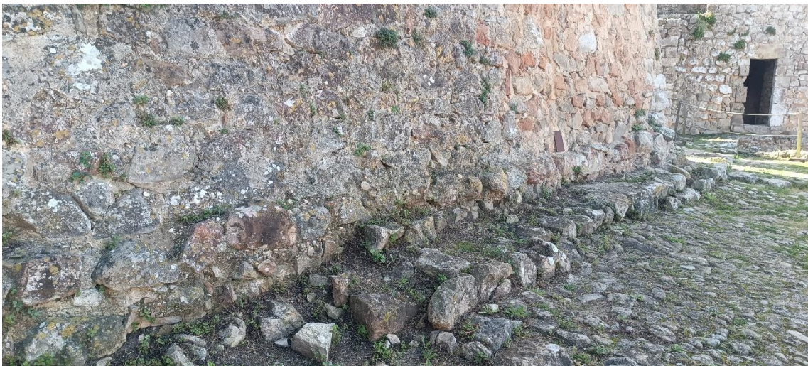
Foto 86 – Vestígio de muro junto alambor da face principal da torre de menagem.
