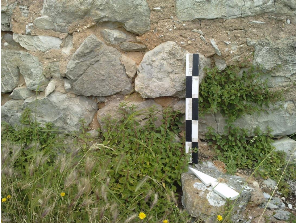
Foto 31 – Pormenor de aparelho do torreão D.
