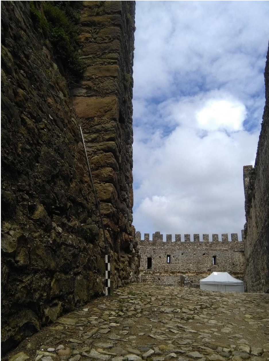
Foto 76 – Pormenor de uma das faces do alambor e contraforte da torre de menagem.
