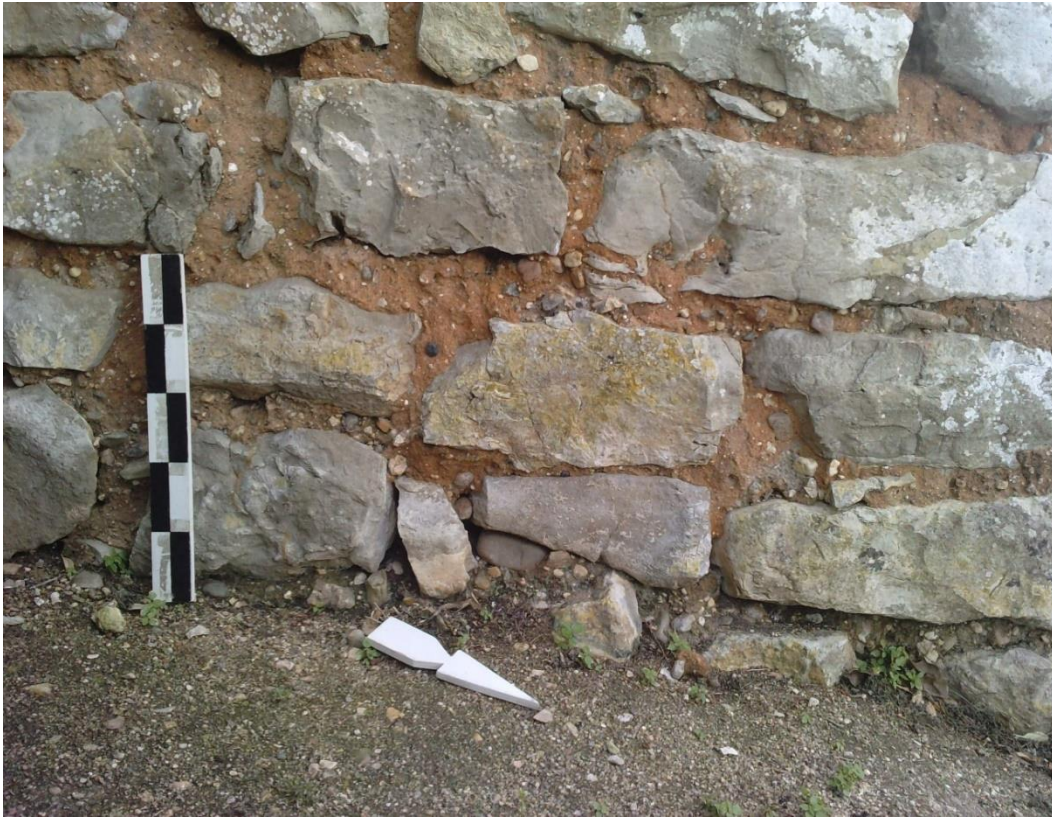
Foto 47 – Pormenor de aparelho no torreão F.
