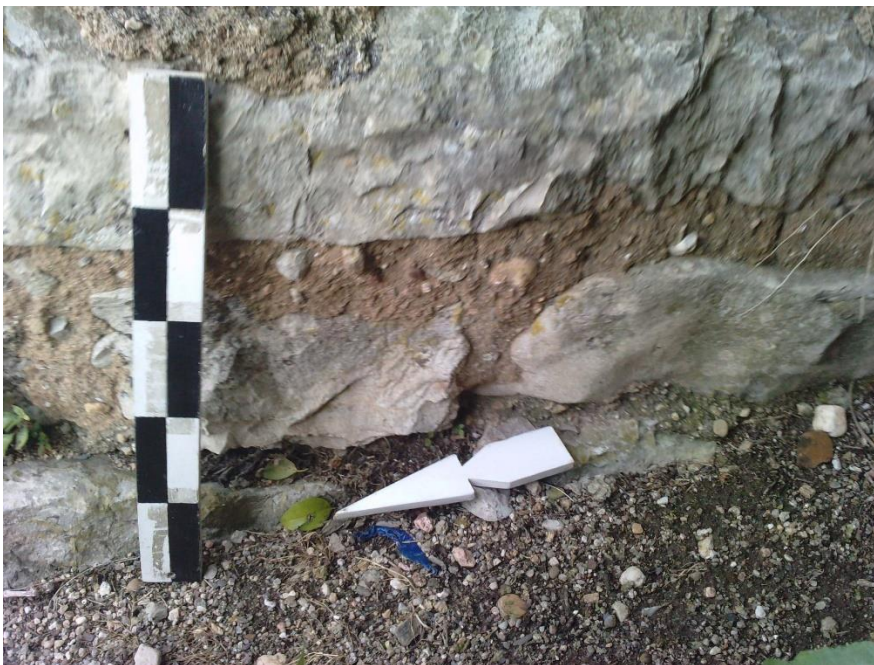
Foto 49 – Pormenor de aparelho no pano de muralha 6.
