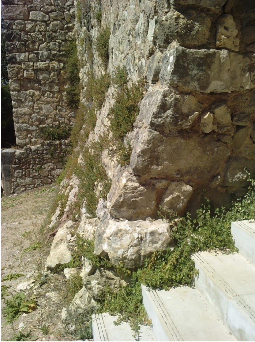
Foto 2 – Pormenor do alambor no torreão A.
