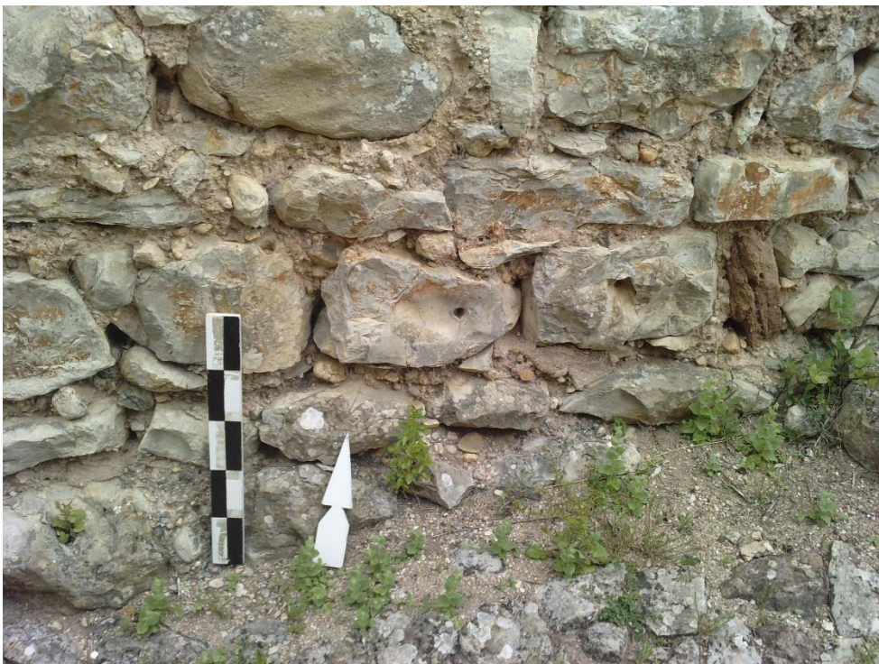
Foto 9 – Pormenor de aparelho do torreão B.
