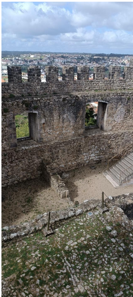
Foto 25 – Janelas no pano de muralha 3 (a partir do interior do castelo).
