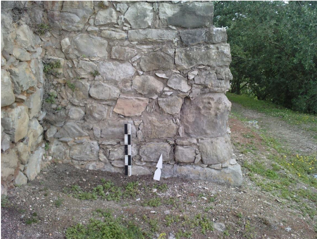
Foto 65 – Pormenor do aparelho do torreão I.
