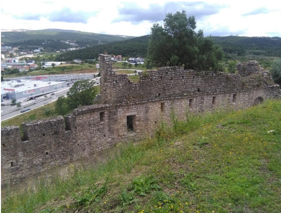
Foto 8 – Parte de barbacã e torreão L.
