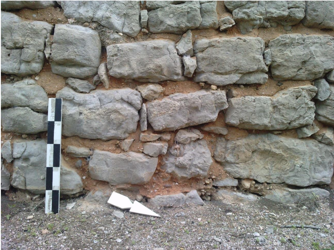
Foto 56 – Pormenor de aparelho do pano de muralha 7.
