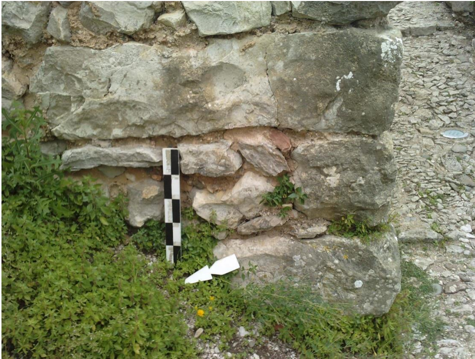
Foto 8 – Pormenor de aparelho do torreão B.
