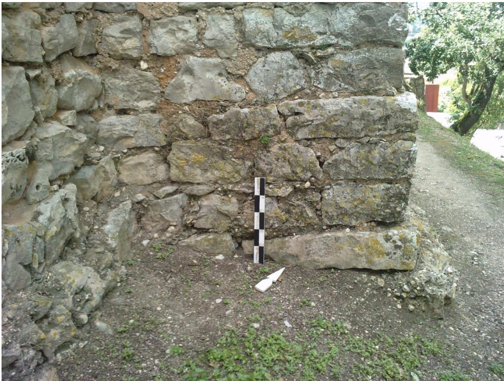
Foto 59 – Pormenor de aparelho no torreão H.
