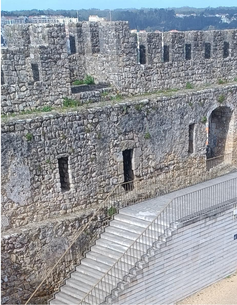
Foto 29 – Entrada para o torreão D.
