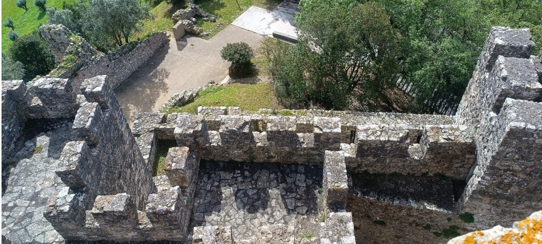
Foto 4 – Vista de cima para o terraço do torreão A.
