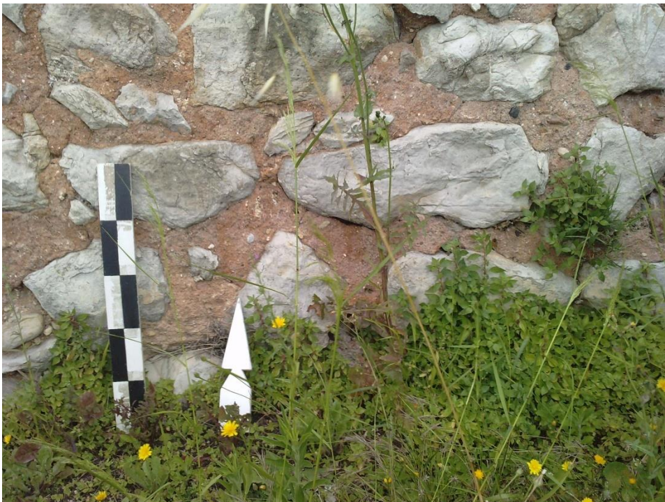
Foto 27 – Pormenor de aparelho no pano de muralha 3.
