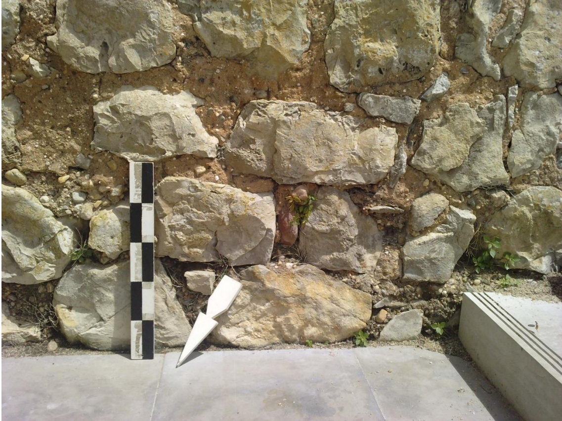
Foto 43 – Pormenor de aparelho do pano de muralha 5.
