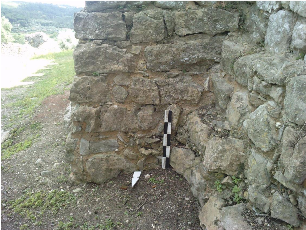
Foto 67 – Pormenor do aparelho do torreão I.
