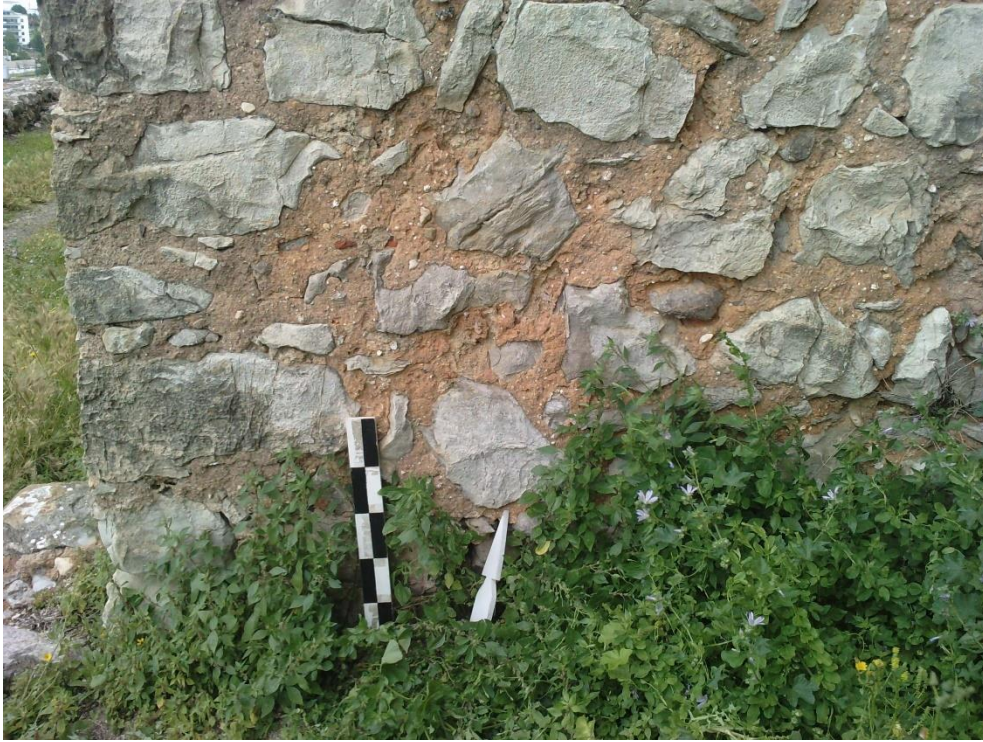
Foto 32 – Pormenor de aparelho do torreão D.
