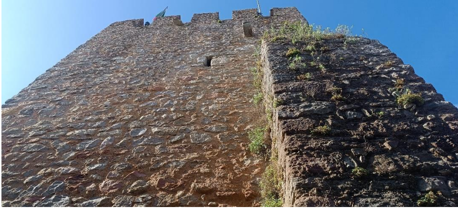
Foto 77 – Pormenor de uma das faces e contraforte da torre de menagem.
