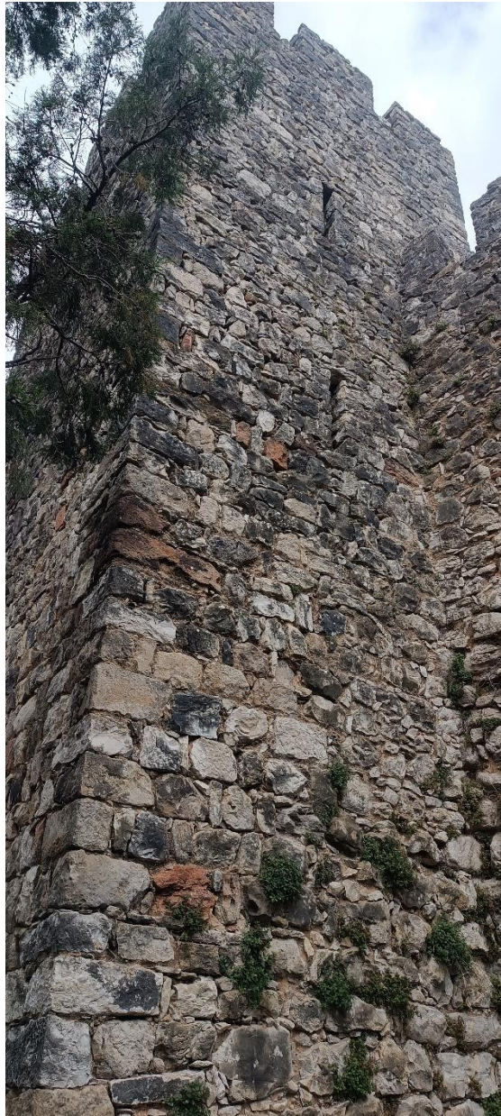
Foto 17 – Torreão C (face voltada para o pano de muralha 2).
