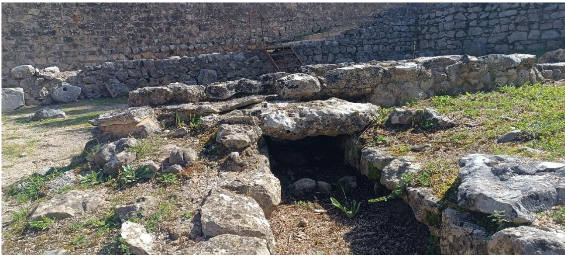
Foto 90 – Pormenor de sistema de drenagem de água no pátio.
