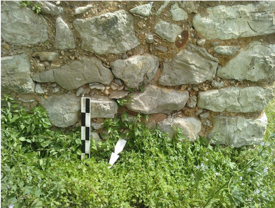
Foto 30 – Pormenor de aparelho do torreão D.
