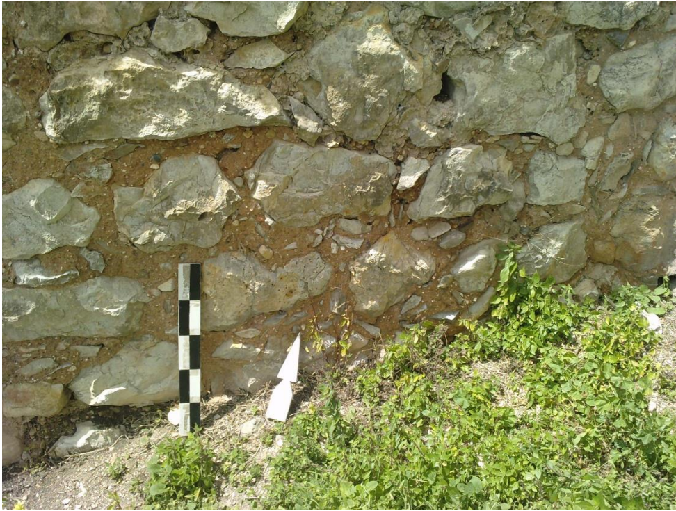
Foto 41 – Pormenor de aparelho do torreão E.
