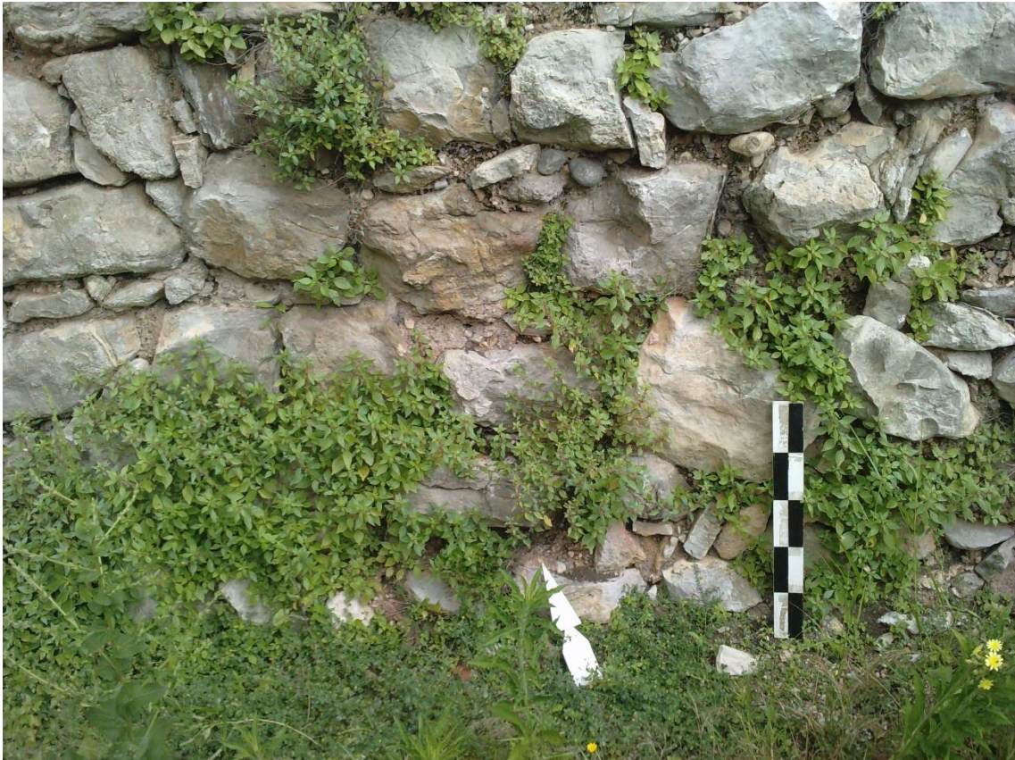
Foto 11 – Pormenor de aparelho do pano de muralha 2.
