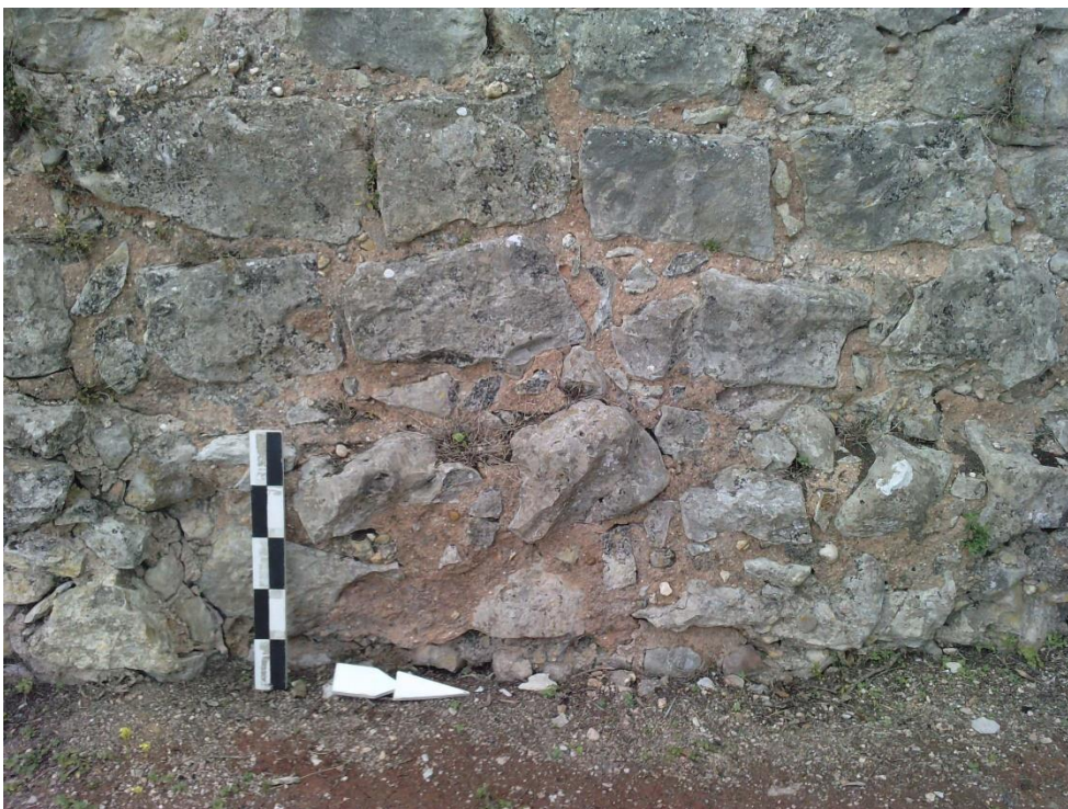
Foto 66 – Pormenor do aparelho do torreão I.
