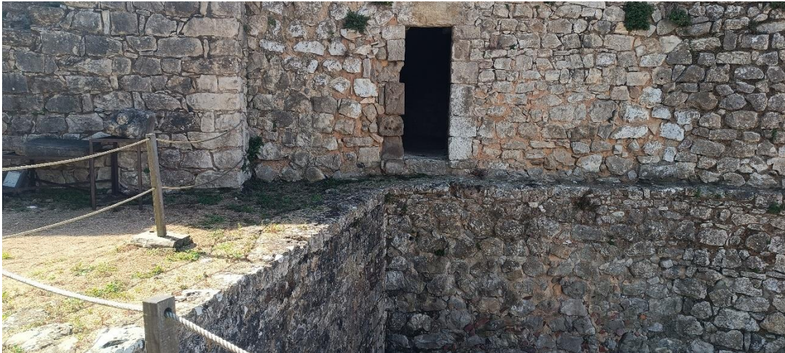
Foto 19 – Entrada para o andar de baixo do torreão C.
