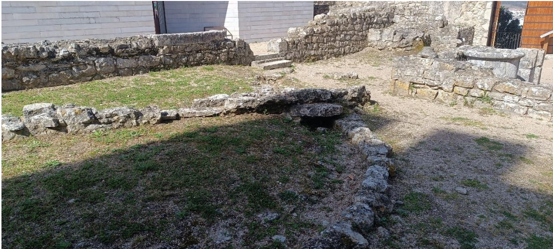
Foto 89 – Sistema de drenagem de água no pátio.
