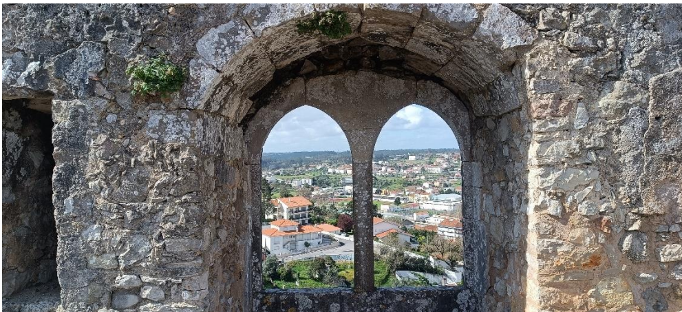
Foto 35 – Janela no pano de muralha 4 (vista do interior).
