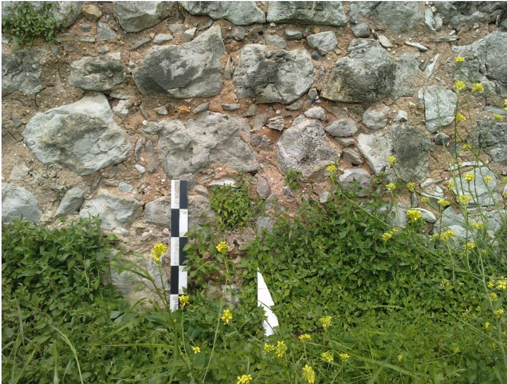
Foto 26 – Pormenor de aparelho no pano de muralha 3.
