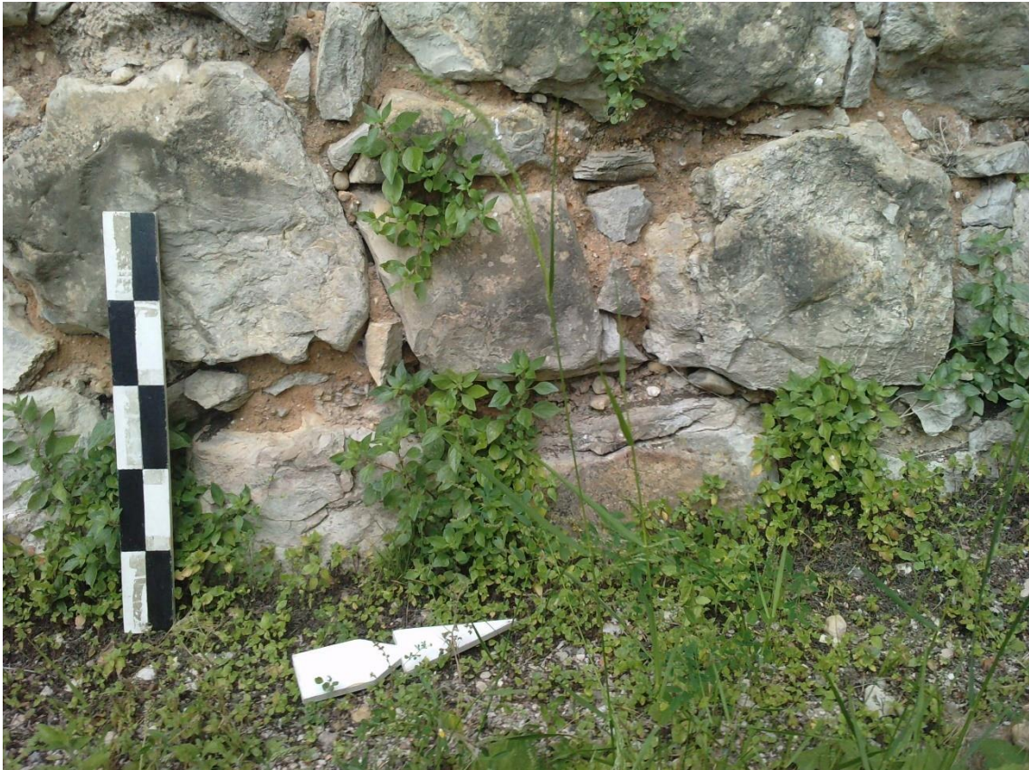
Foto 23 – Pormenor de aparelho do torreão C.
