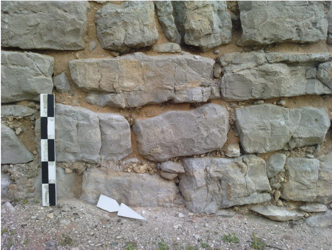
Foto 53- Pormenor de aparelho do torreão G.
