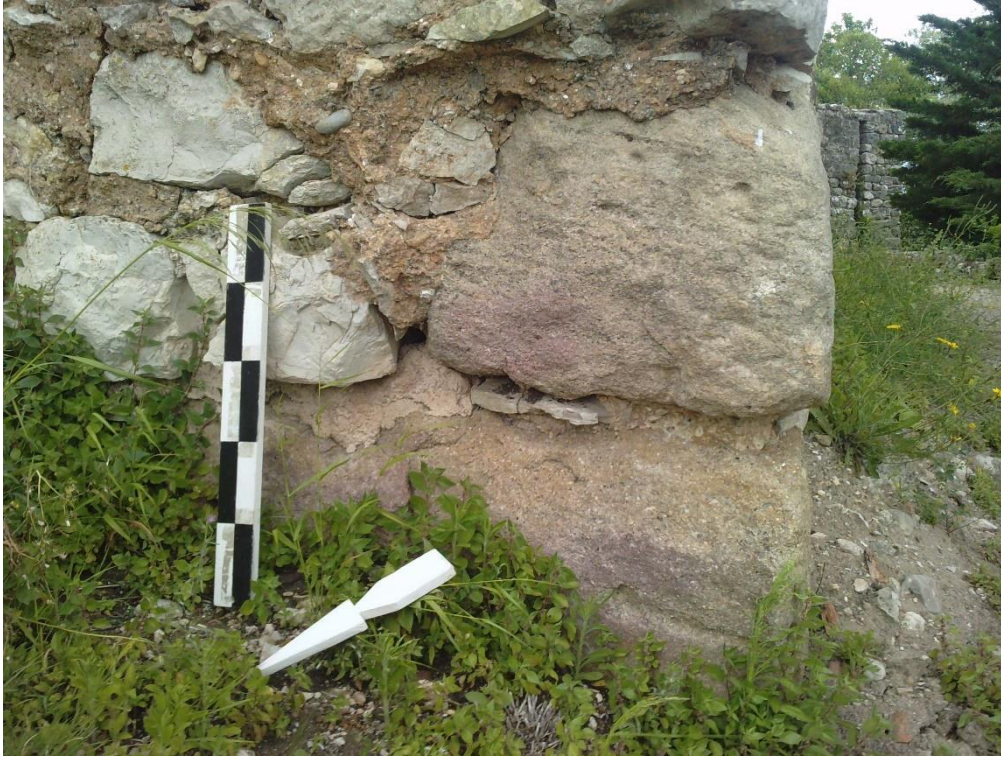
Foto 21 – Pormenor de aparelho do torreão C.
