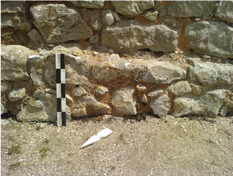
Foto 48 – Pormenor de aparelho no torreão F.
