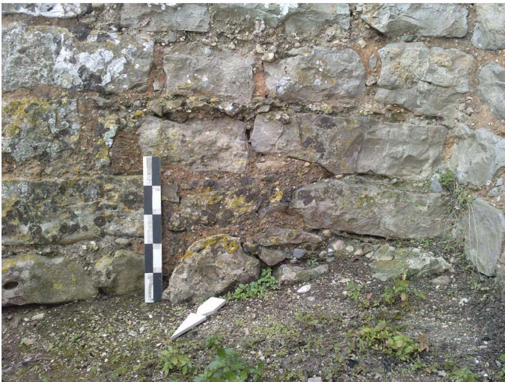
Foto 61 – Pormenor de aparelho no torreão H.
