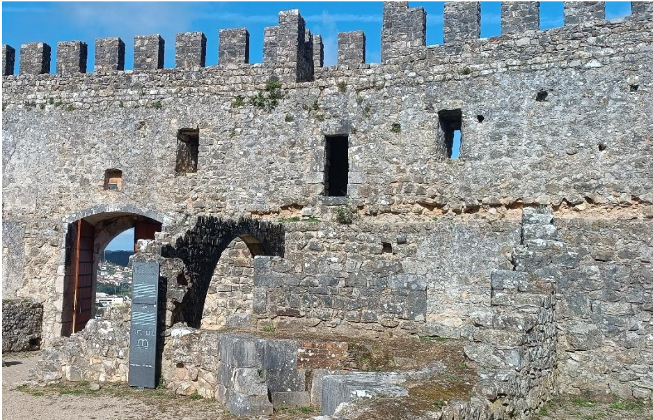
Foto 45 – Entrada para o torreão F.
