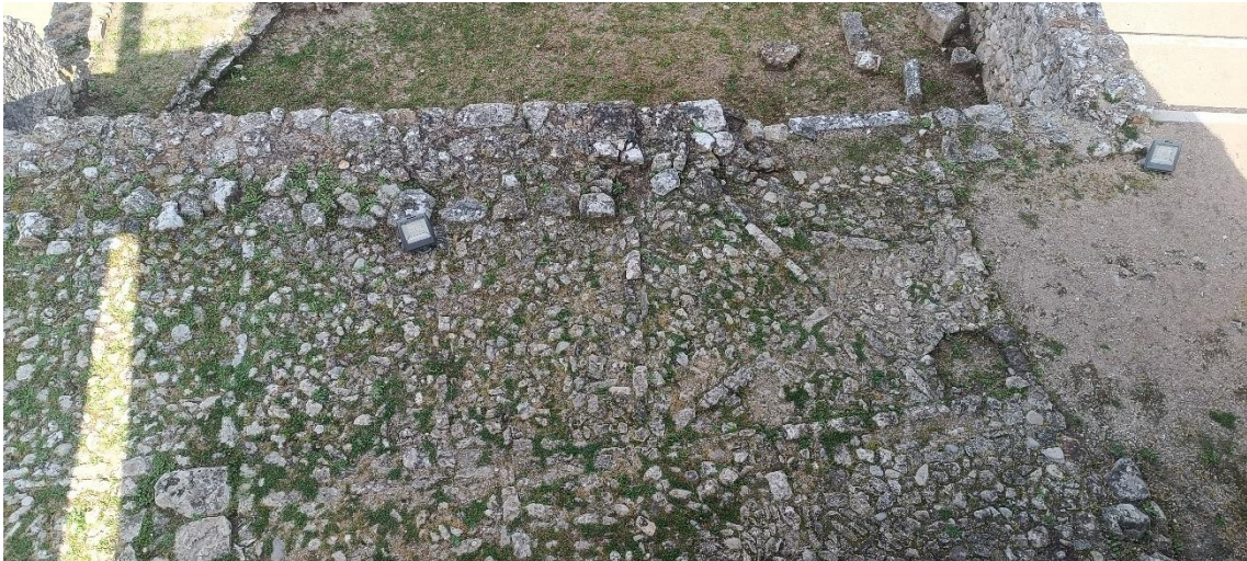
Foto 83 – Pavimento junto à face principal da torre de menagem.
