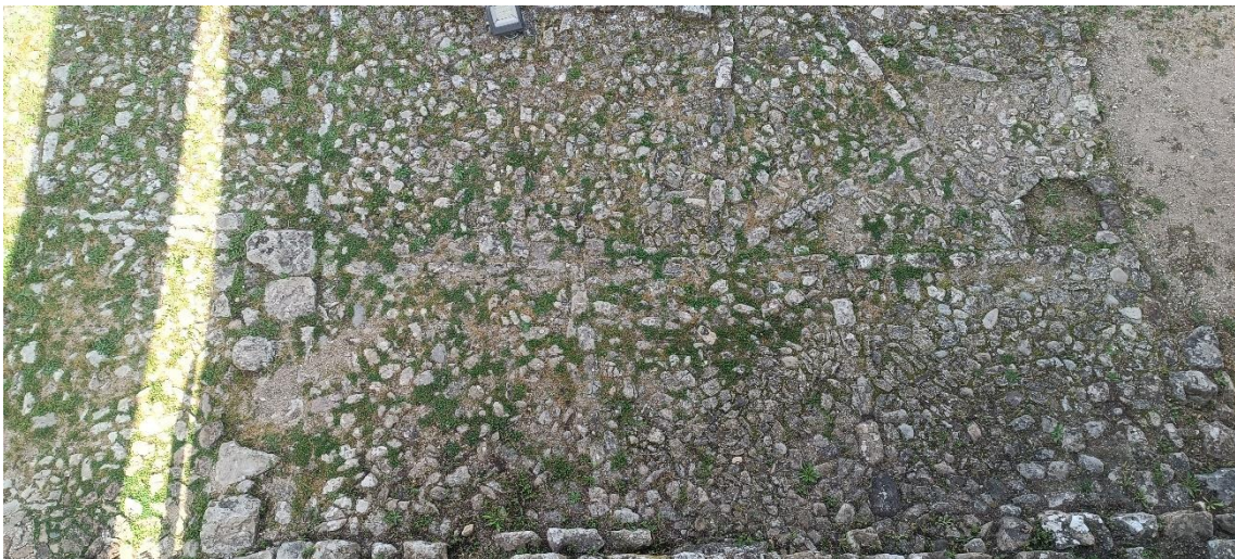
Foto 84 – Pavimento junto à face principal da torre de menagem.
