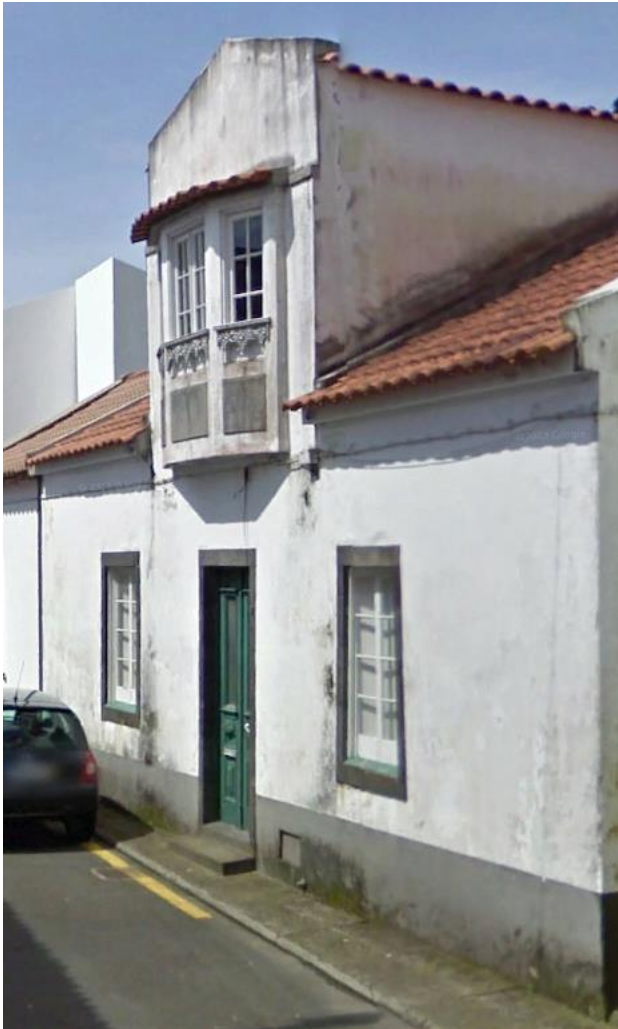
Figura 49: Casa "achalezada" de águas paralelas à fachada janela-porta-janela, Furnas. Fonte: Google Earth.
