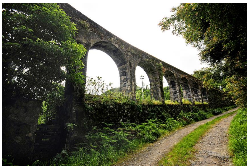
Figura 13: Aqueduto das Furnas. Fonte: Google Imagens.
