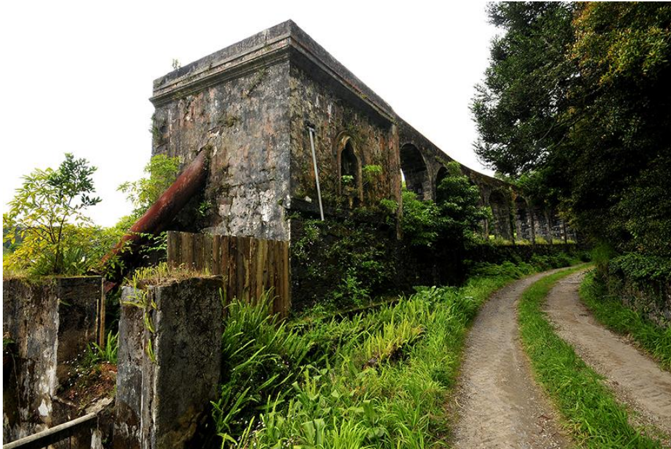
Figura 14: Casa do engenho do aqueduto das Furnas. Fonte: Google Imagens
