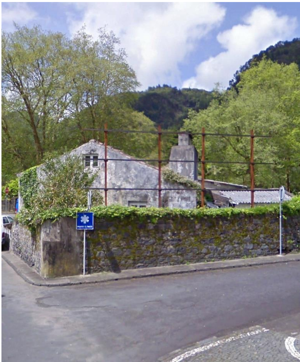
Figura 52: Casa Integrada dobrada, em pior estado de conservação, Furnas. Fonte: Google Earth.
