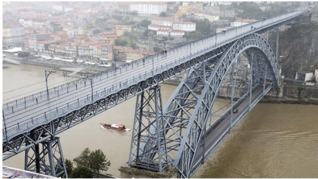
Ponte D. Luís, Porto, 1886
