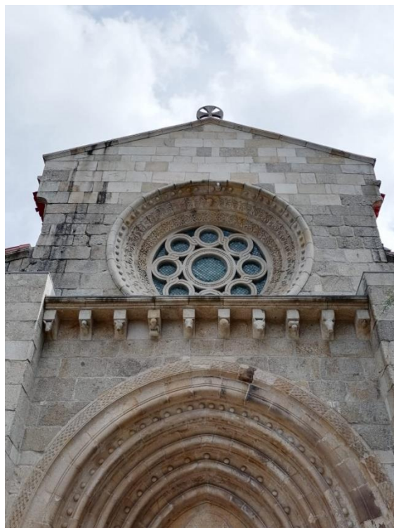
Figura 17: Rosácea da fachada principal do mosteiro e cachorrada na zona inferior
