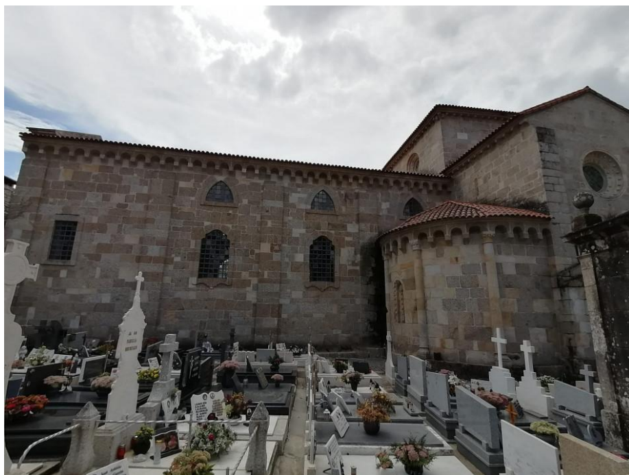
Figura 20: Parede norte da capela-mor
