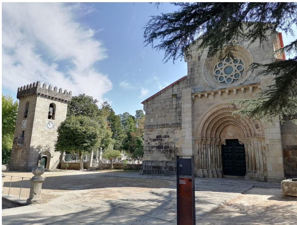
Figura 3: Fachada ocidental do Mosteiro de Paço de Sousa e torre sineira
