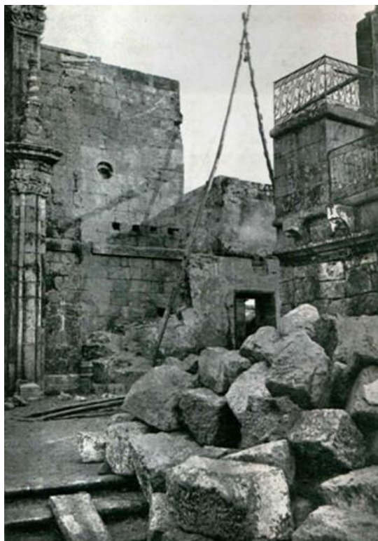
Figura 7: Os trabalhos realizados no mosteiro entre 1927 e 1939 (DGEMN, 1939)
