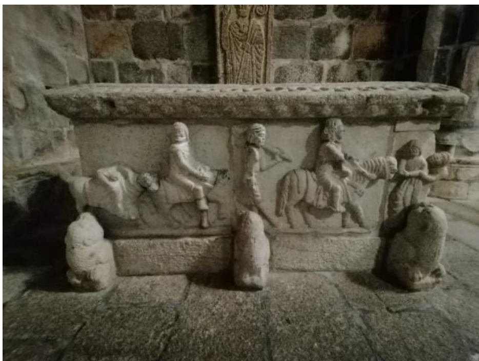
Figura 72: Face lateral que comunica com a nave sul do templo
