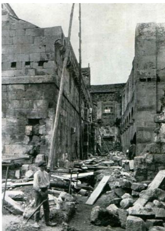
Figura 8: Trabalhos de restauro na fachada sul do templo (DGEMN, 1939)
