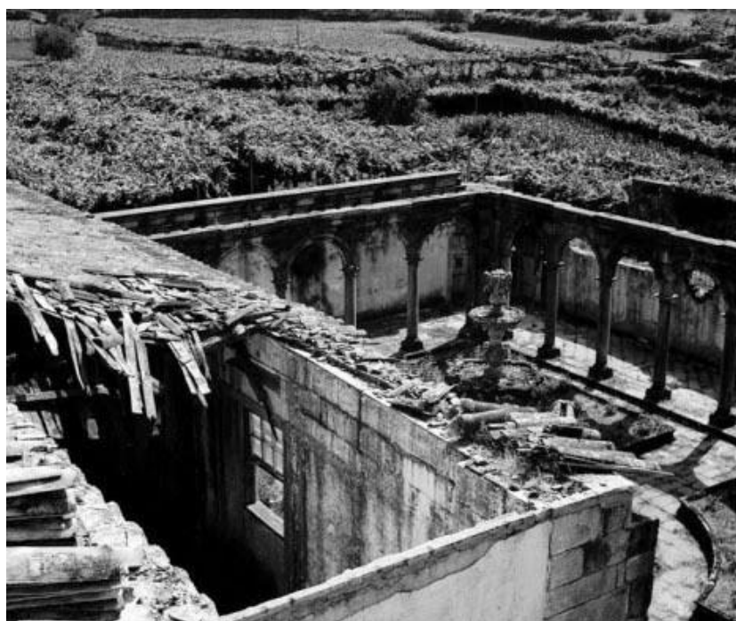
Figura 6: O claustro do mosteiro após o incêndio de 1927 (Fernando Oliveira 2014)
