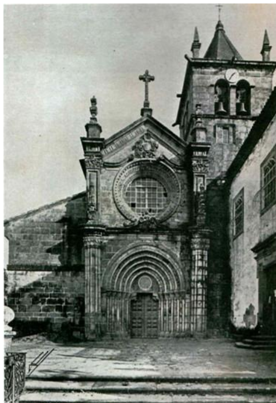
Figura 11: A fachada principal antes dos trabalhos de restauro (DGEMN, 1939)
