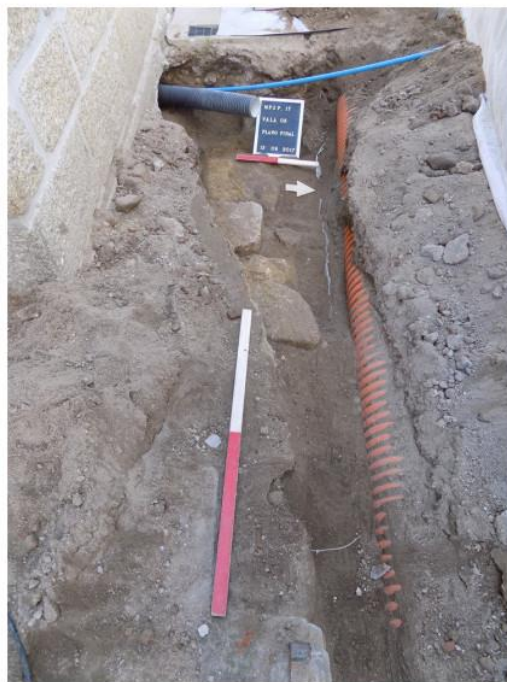
Figura 67: Plano Final da vala 05 na entrada do claustro (Arqueologia e Património, 2017)
