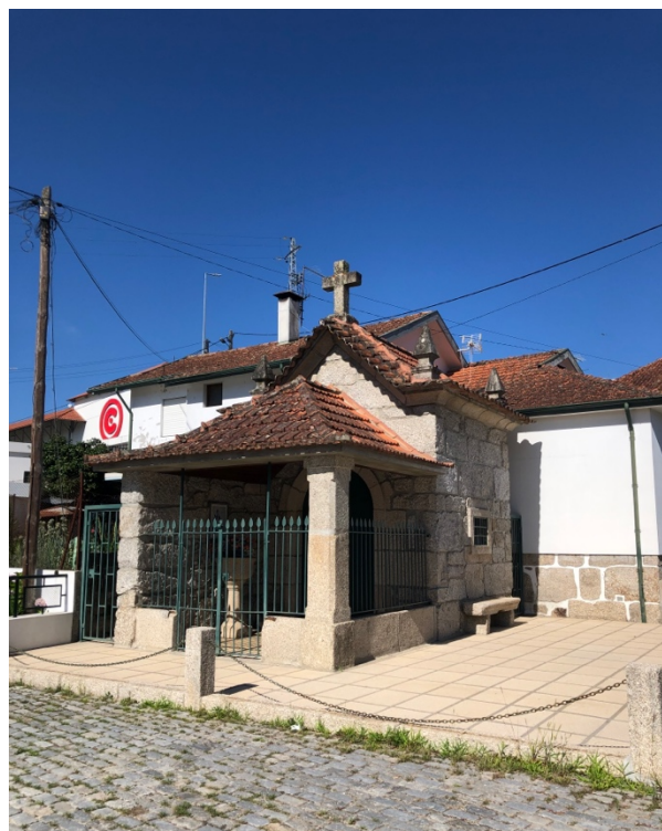
Fotografia 8 — Capela de São Lázaro, na UF Amarante (São Gonçalo), Madalena, Cepelos e Gatão, em Amarante. Fotografia da autora.
