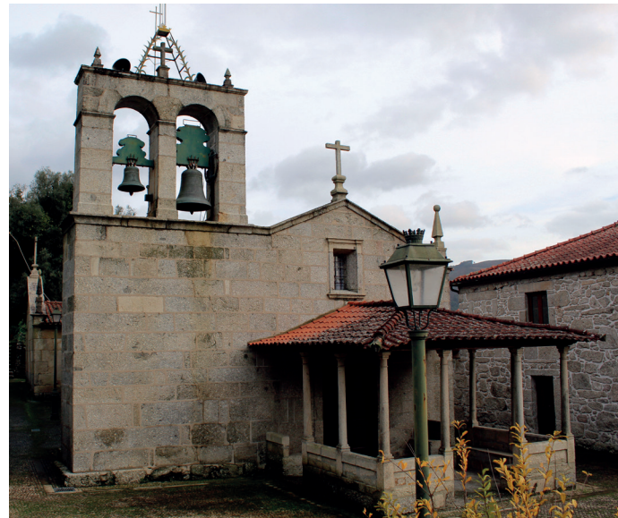
Perspetiva geral da igreja. Alçado oeste
