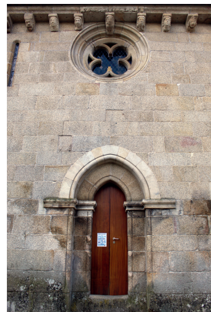
Alçado norte da nave. Portal e rosácea
