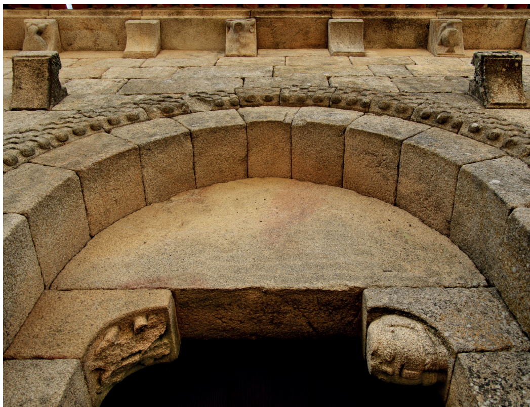
Pormenor do portal sul
