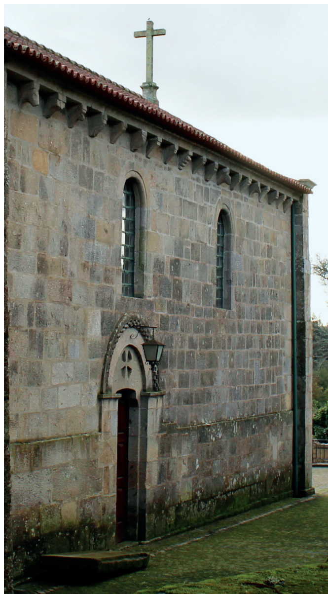
Alçado norte. Aspeto geral da nave
