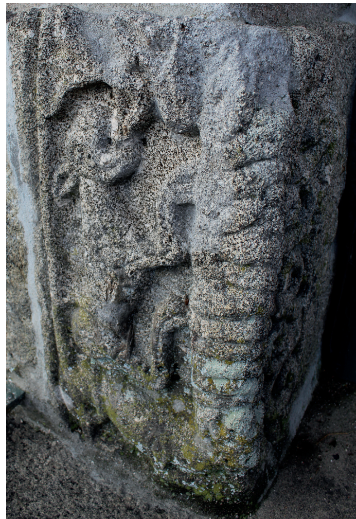
Silhar decorado, localizado junto à porta lateral (elevada) da fachada sul
