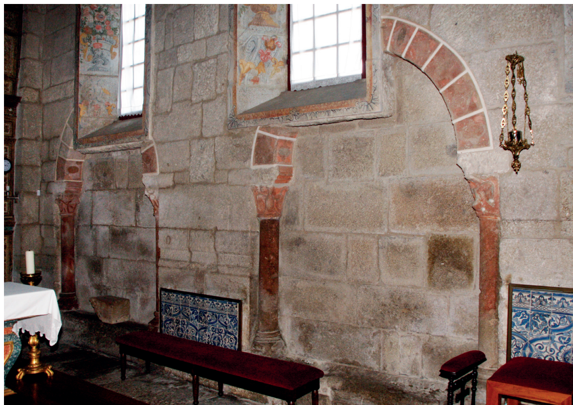
Interior. Abside. Muro norte. Arcos entaipados
