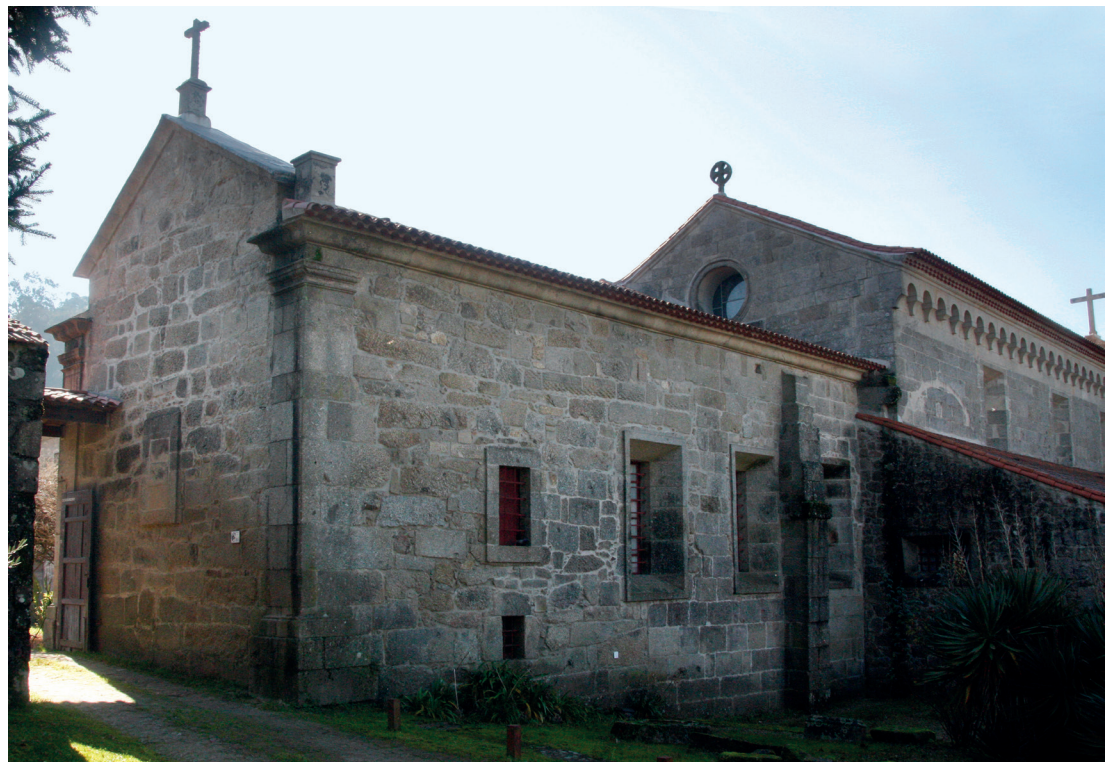
Exterior. Perspetiva geral da igreja. Alçados este e norte
