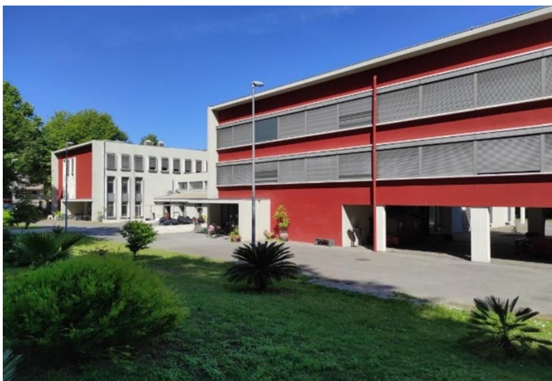
Figura 1- Espaço Exterior ESAS ( www.aesas.pt ).
