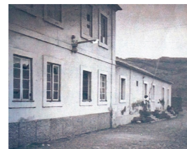
Fig. 73: Alçado lateral direito antes das intervenções. O bloco principal em conformidade com o volume que pertencia a regedoria do concelho (acesso pela rua).
