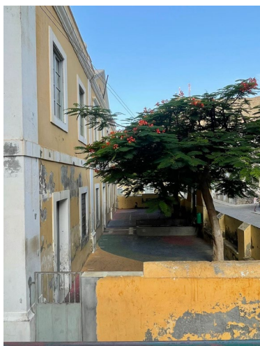
Fig. 54: Pátio frontal que dá acesso ao edifício (não sofreu alterações durante as intervenções).
