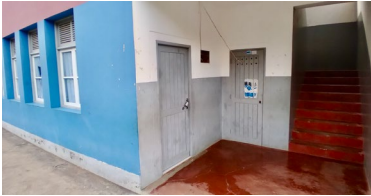
Fig. 121: Espaço de circulação no bloco frontal.
