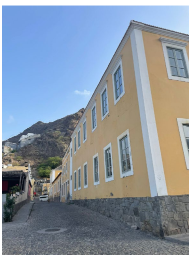
Fig. 68: O volume mais novo em harmonia com os restantes blocos interligados.
