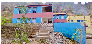
Fig. 117: Vista frontal da escola. Vestígio da antiga entrada da escola.
