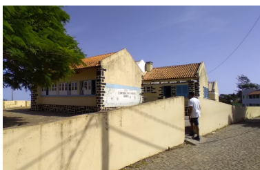
Fig. 109: Entrada da Escola de Corda.
