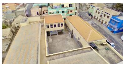
Fig. 97: Vista de cima da Escola de Ponta do Sol.
