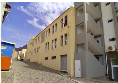
Fig. 101: Vista do alçado posterior da escola.
