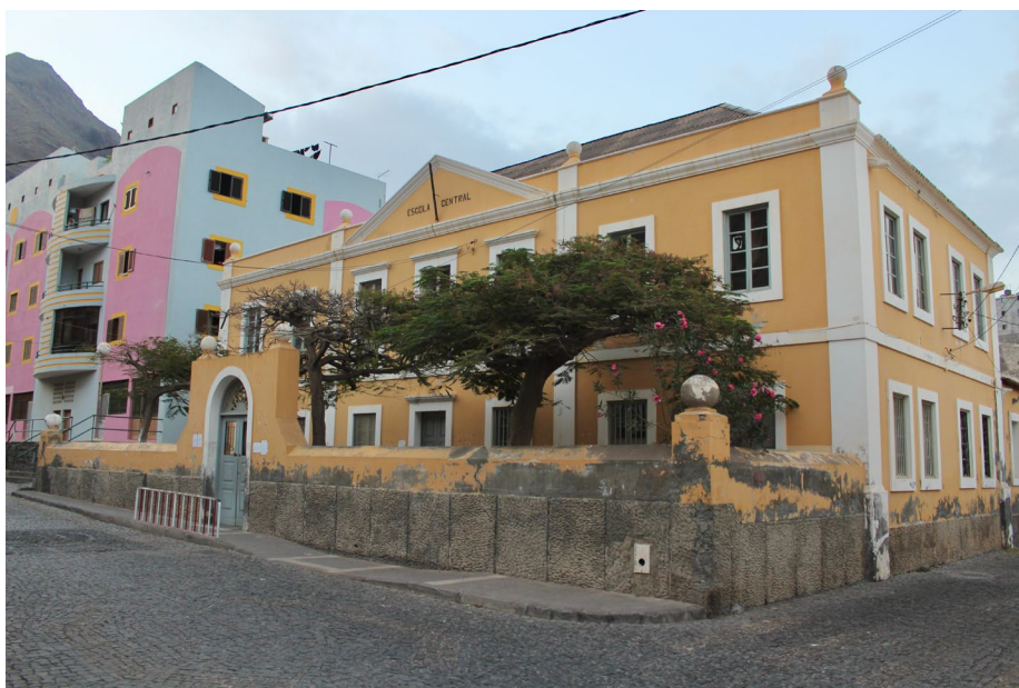
Fig. 56: Composição volumétrica do bloco principal da Escola Central, e os elementos que compõem a sua fachada.
