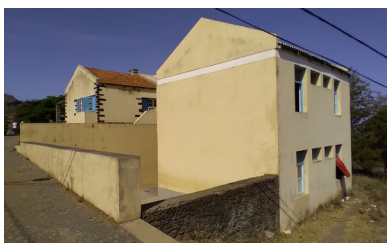
Fig. 110: O novo volume em concordância com o espaço escolar.
