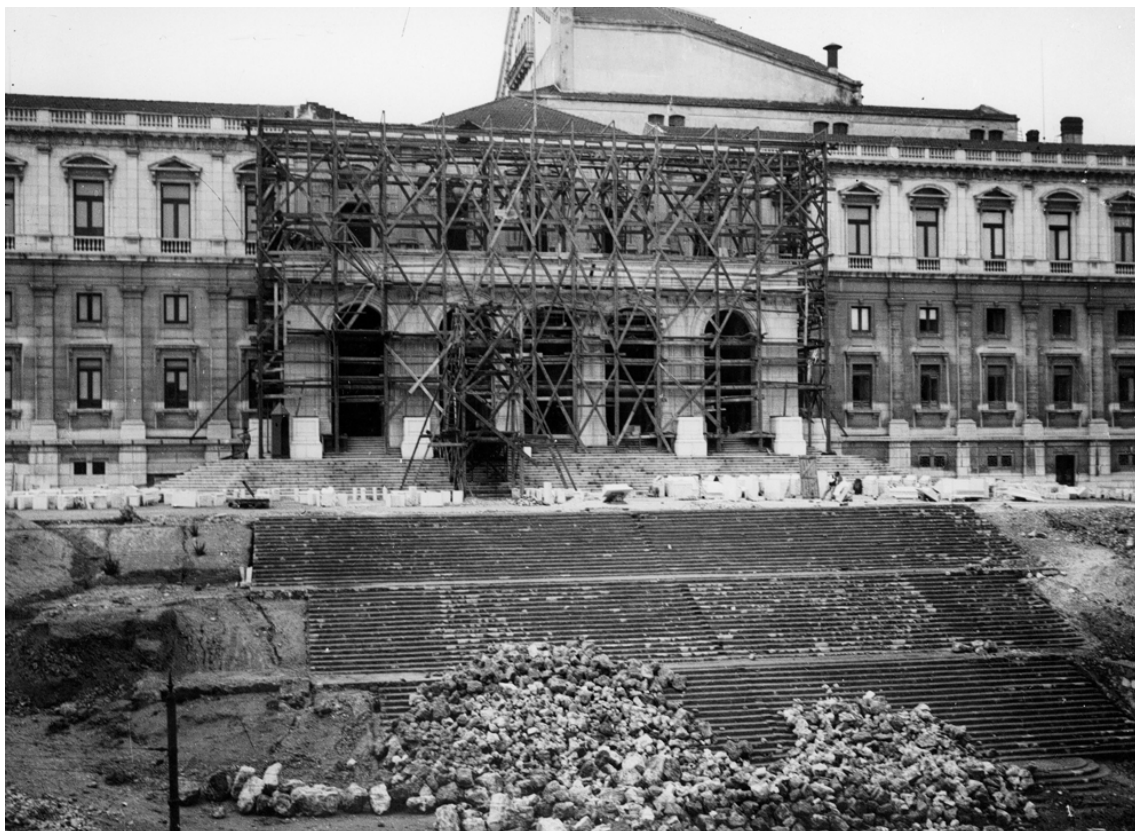
Aspetto das obras na fachada principal do Palácio de São Bento, 23 de novembro de 1935.
