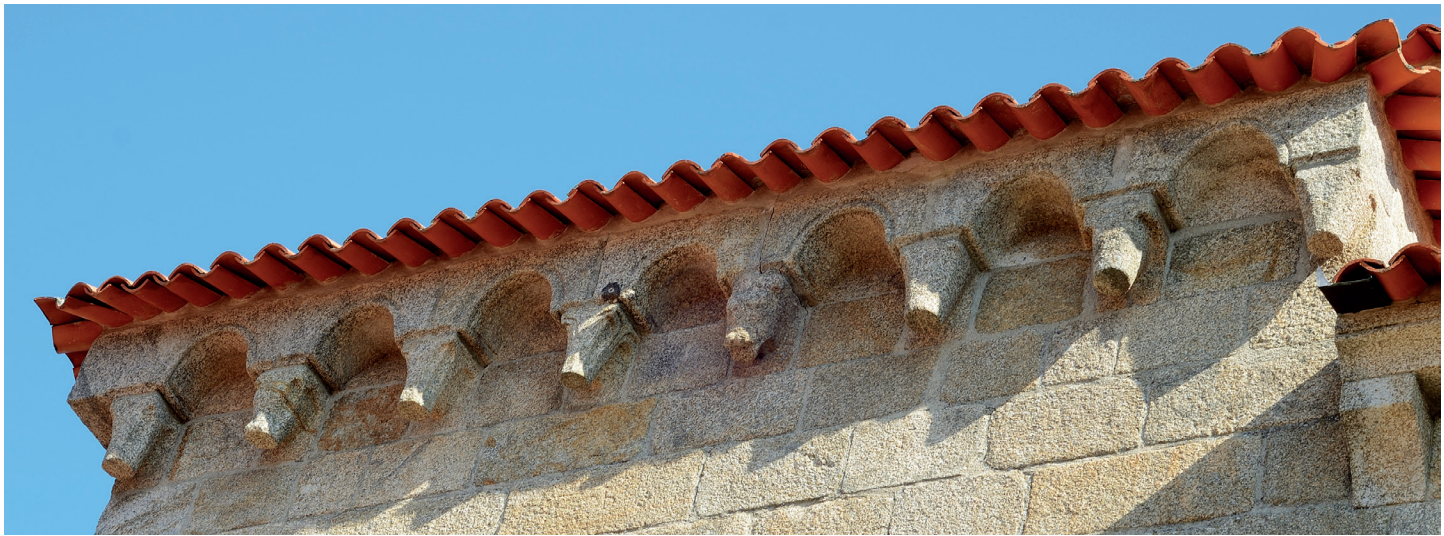
Alçado sul do maciço turriforme ocidental. Cachorros
