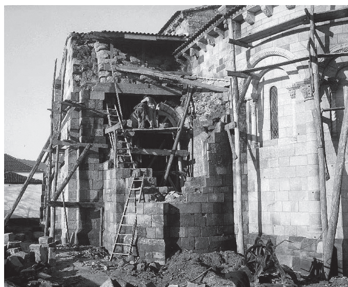
Obras de restauro no absidiólo sul (Foto DGEMN/SIPA-DGPC)
