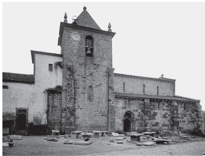
A igreja antes do restauro. Alçado norte (Foto DGEMN/SIPA-DGPC)
