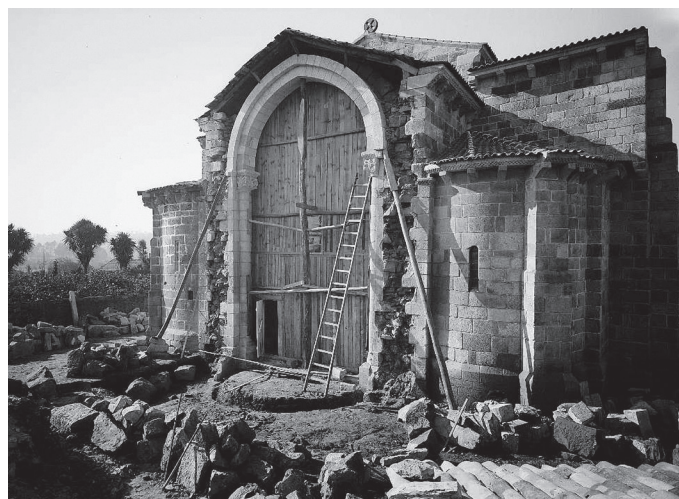
A cabeceira durante as obras de restauro (Foto DGEMN/SIPA-DGPC)
