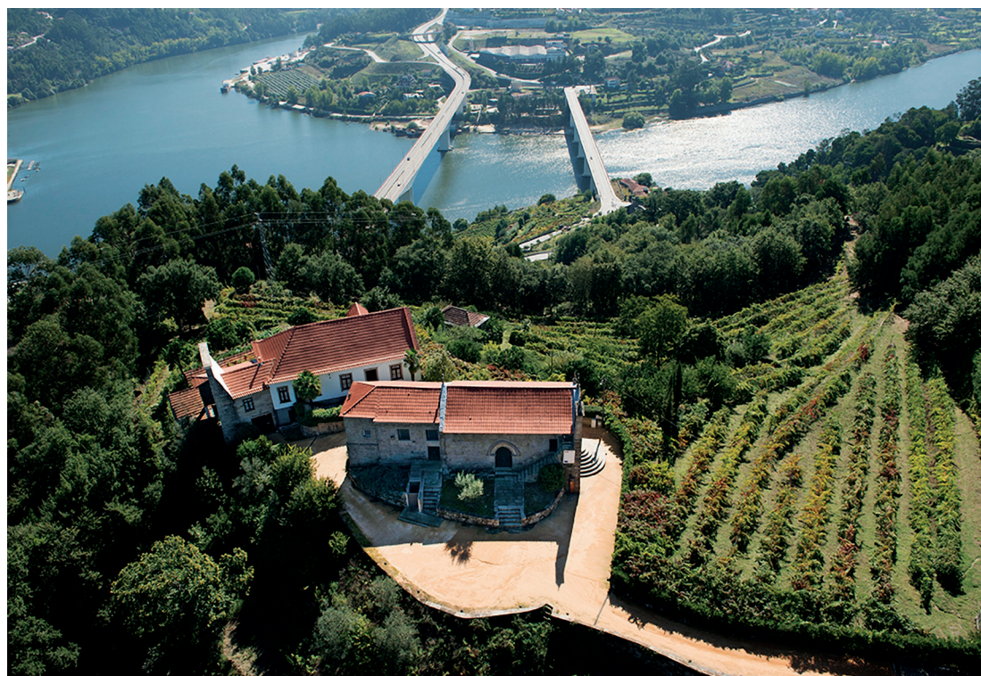
Vista aérea. Implantação da igreja a partir de norte
