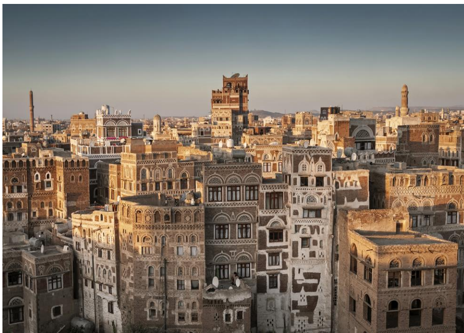
Fig. 9: Imagem da antiga cidade de Sana'a, construída com materiais locais.
