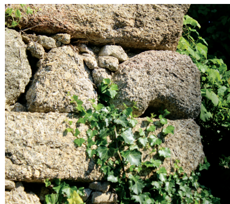
Estruturas murárias incorporando vestígios românicos
