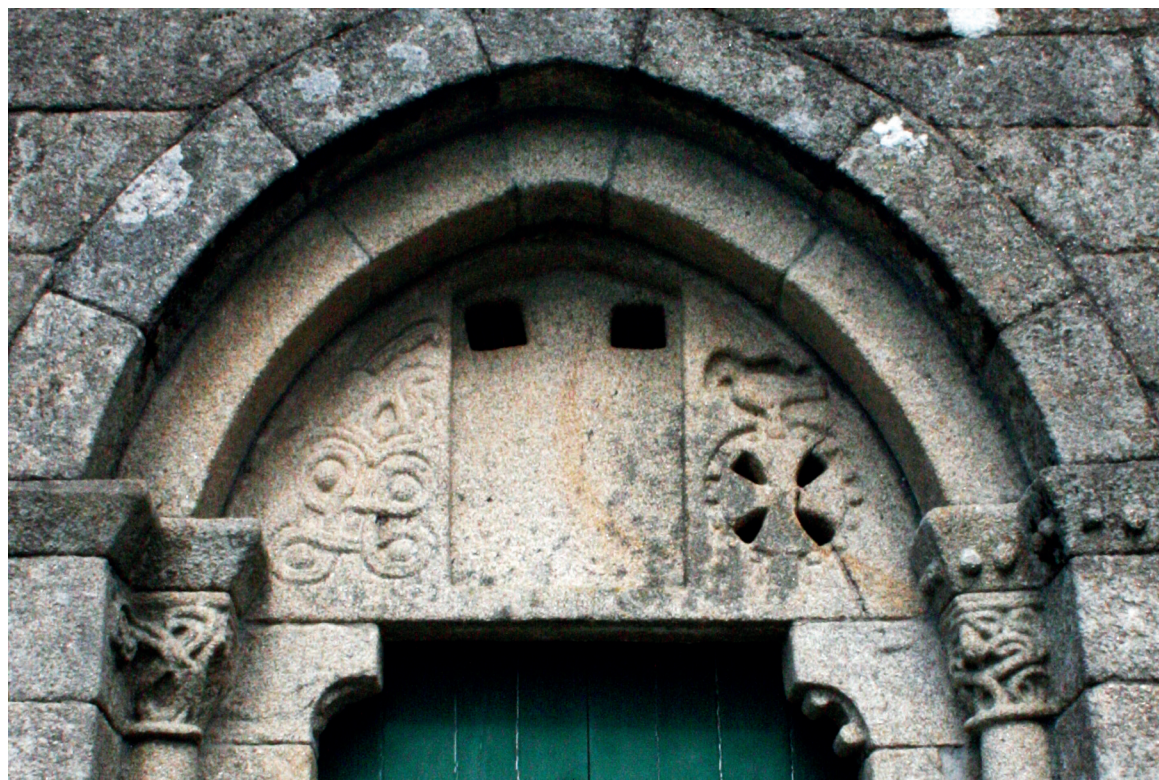
Alçado oeste. Pormenor do portal
