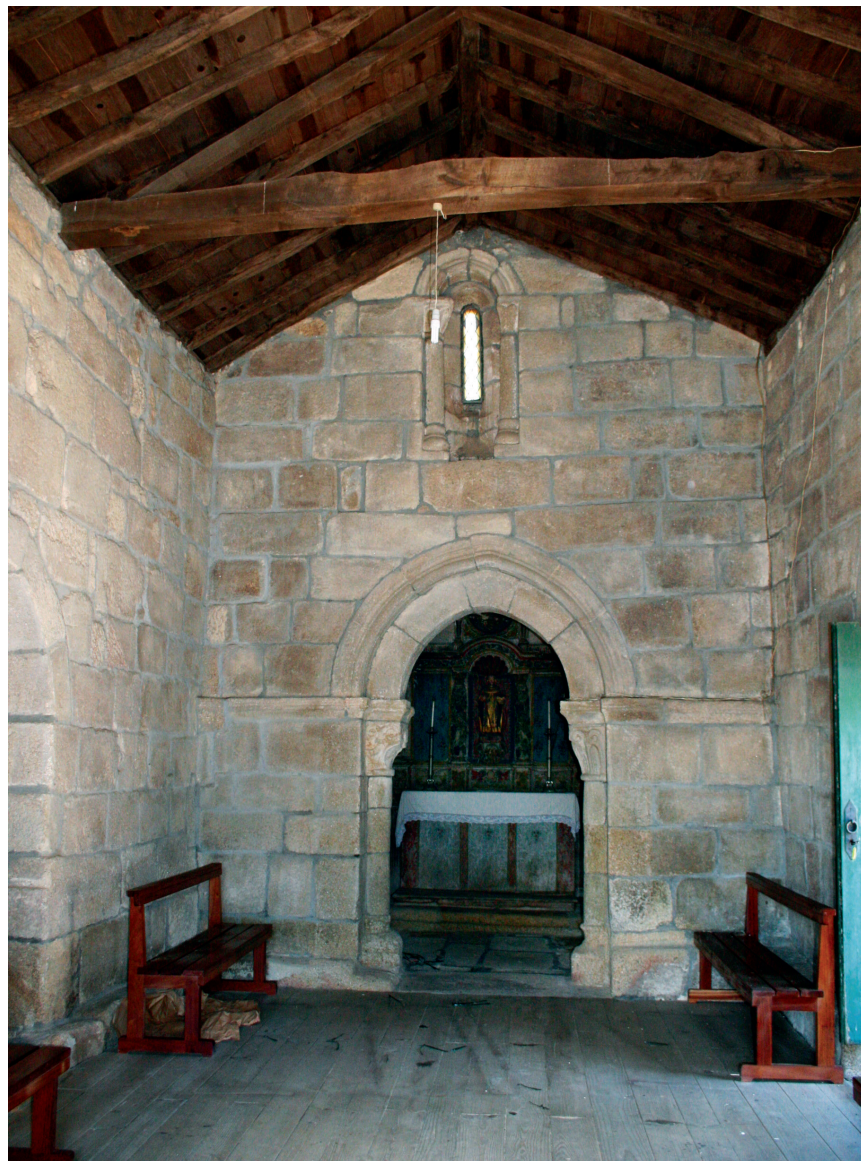
Interior. Perspetiva geral da nave a partir do lado ocidental
