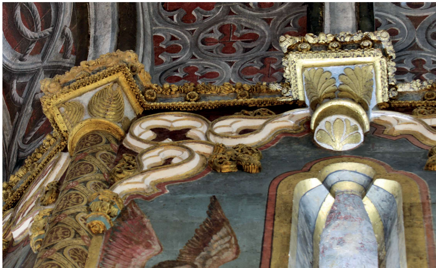
Interior. Nave circundante. Capitéis da abóbada
