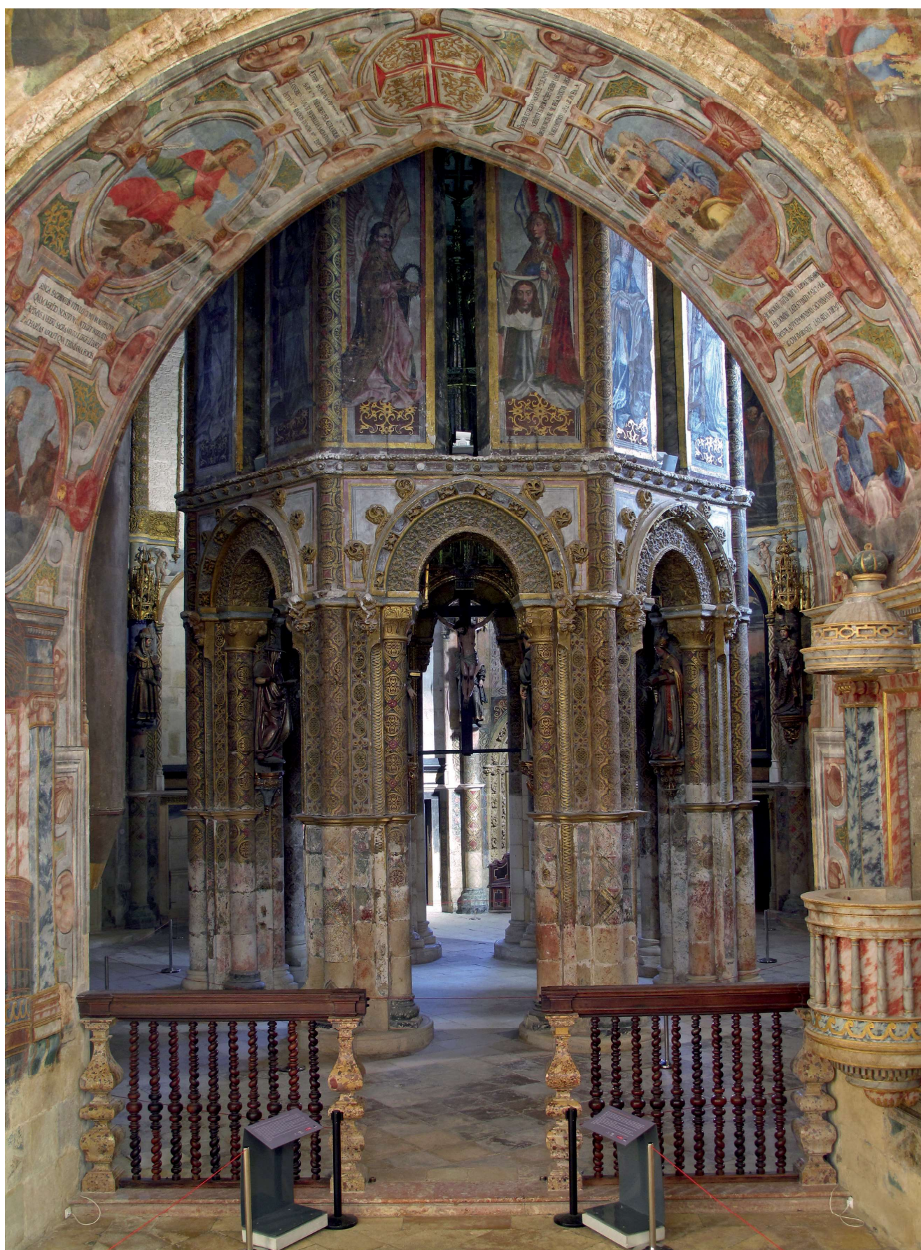
Interior. Arco de ingresso para a nave circular românica a partir da nave manuelina
