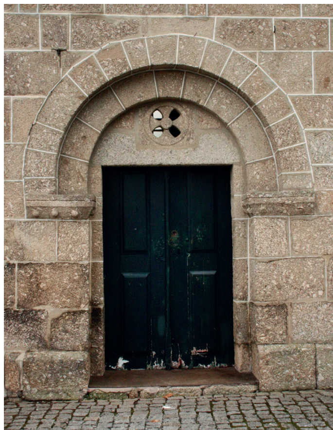
Alçado norte. Portal este (primitivo)
