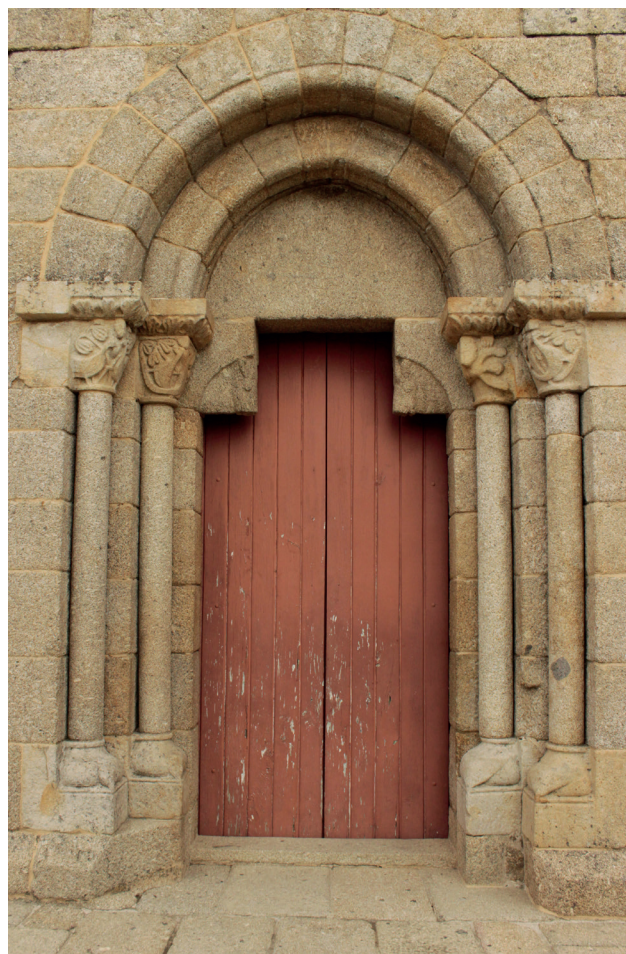
Alçado sul. Portal
