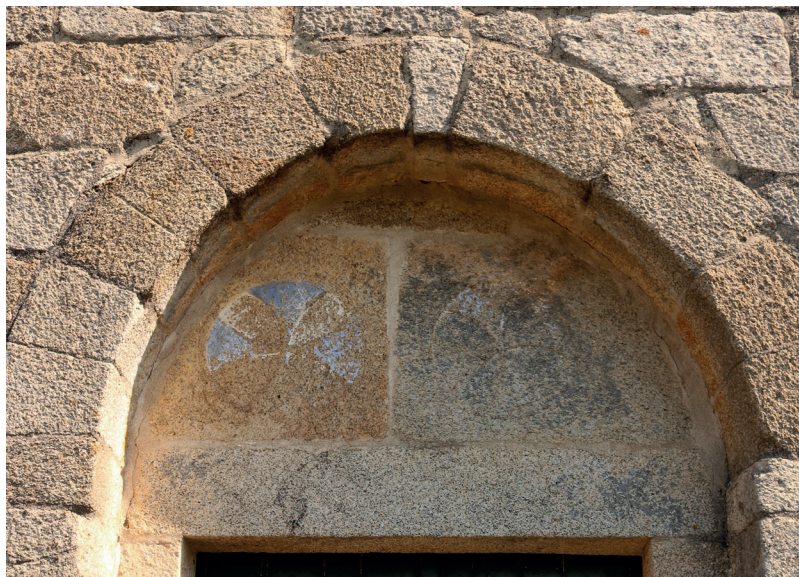
Portal sul. Pormenor
