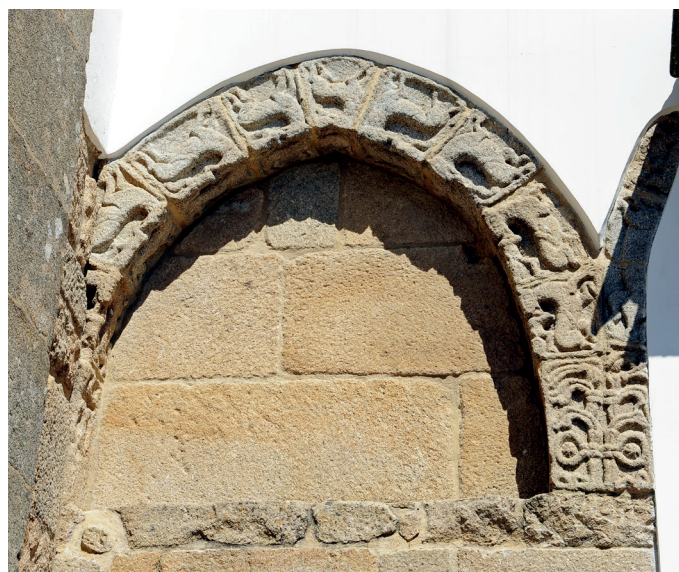
Alçado oeste. Arcadas cegas
