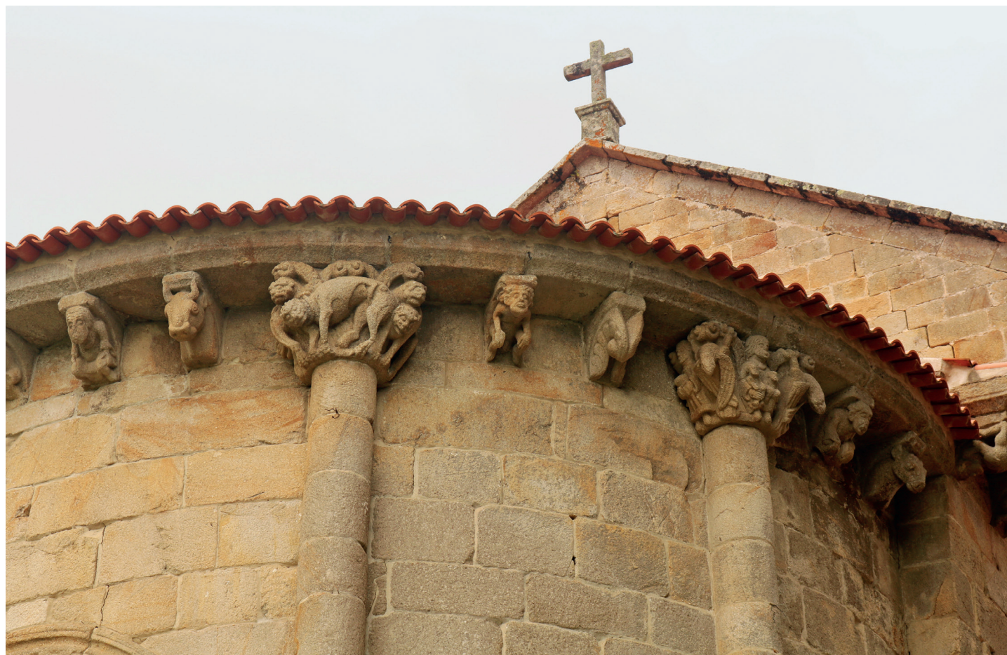
Cornija da abside
