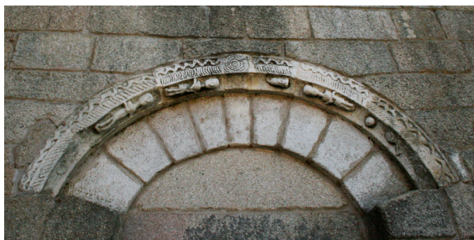
Pormenor do portal norte
