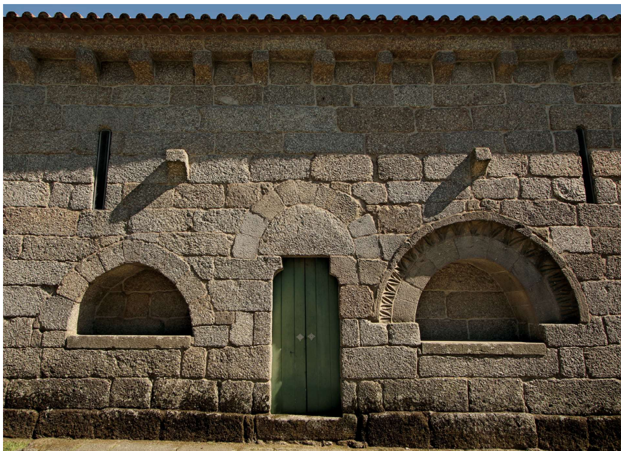
Alçado norte da nave. Portal e arcossólios
