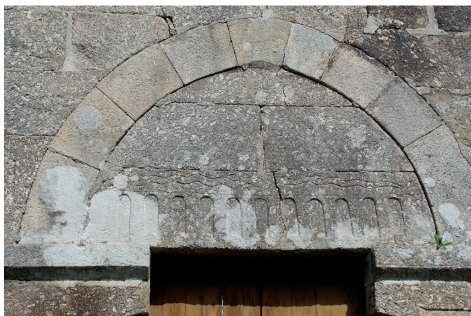
Tímpano do portal sul da igreja
