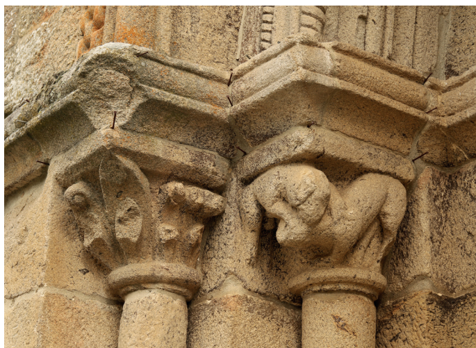
Portal ocidental. Capitéis do lado norte
