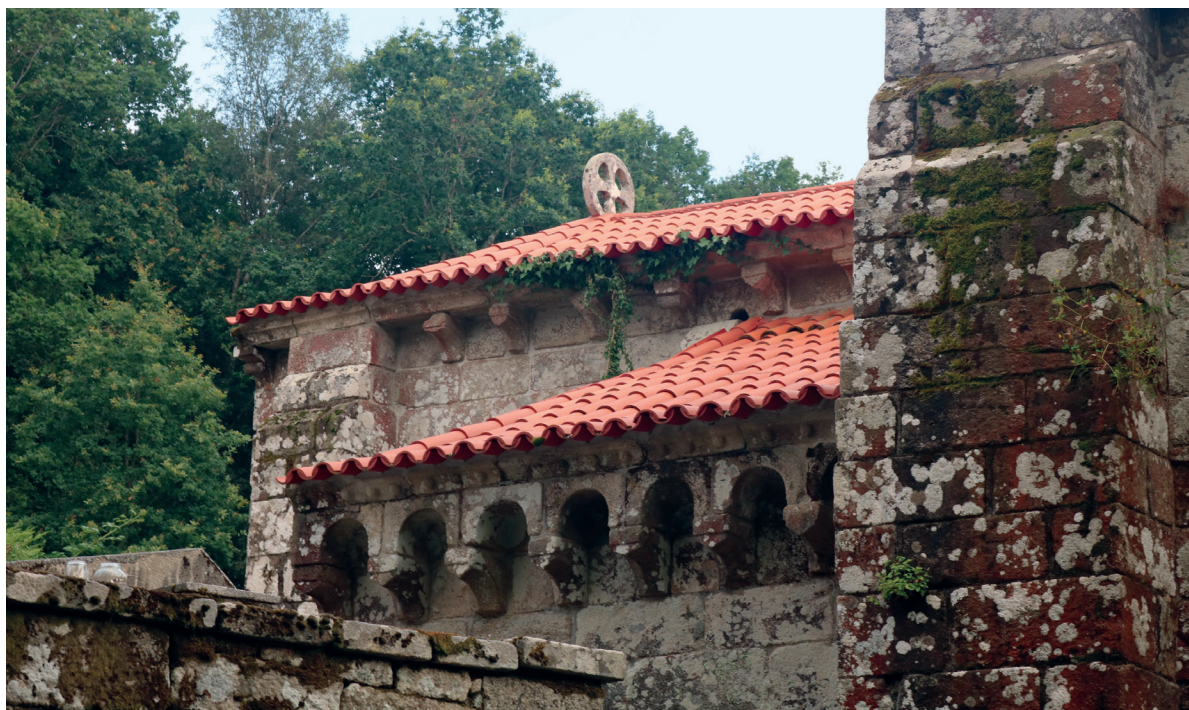
Alçado norte. Pormenor da cabeceira e absidiolo do Evangelho
