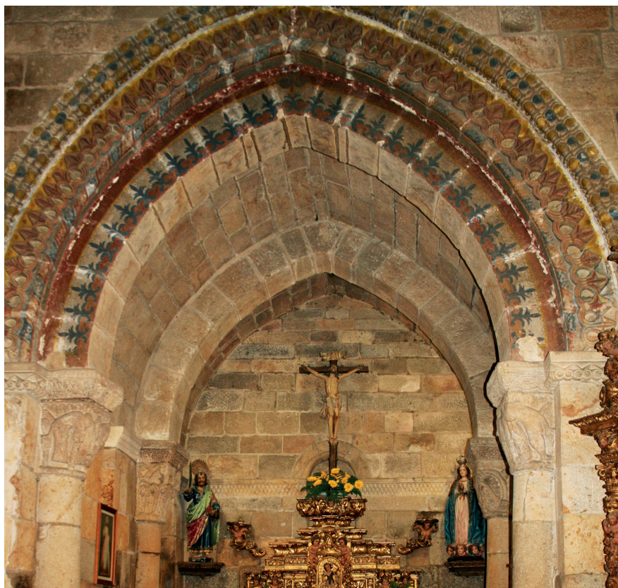
Interior. Pormenor da cabeceira
