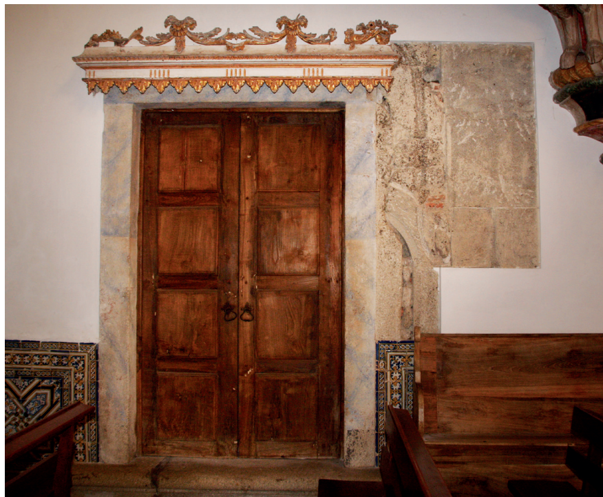
Interior. Nave. Vestígio de paramentos românicos
