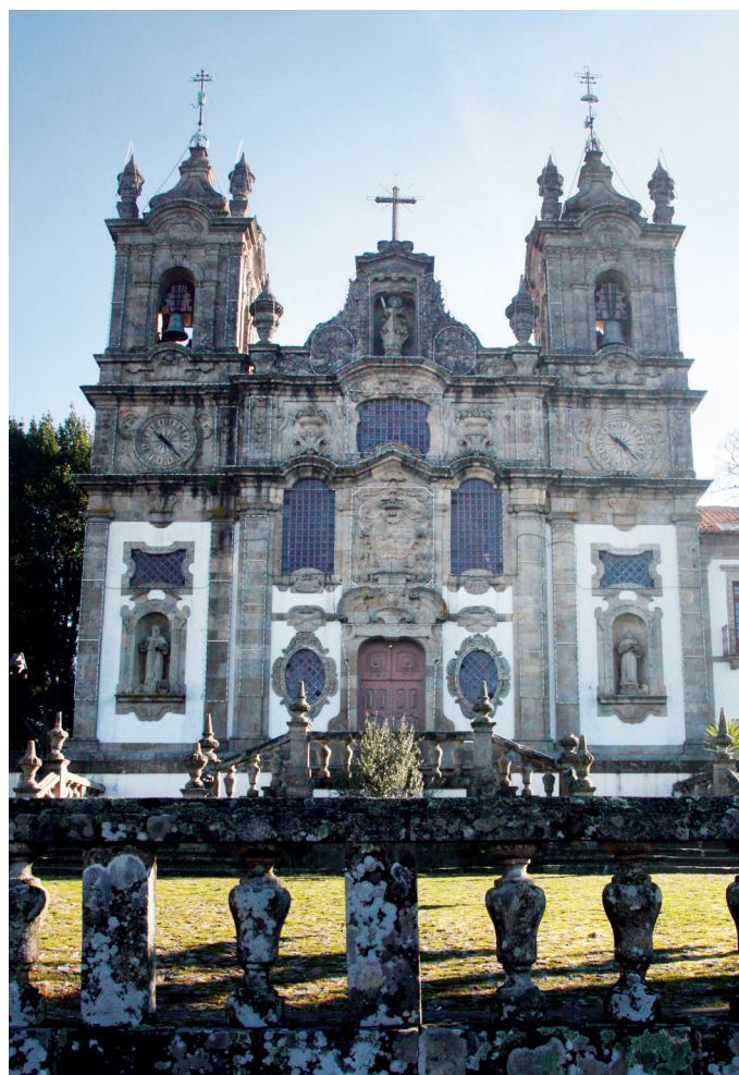
Perspetiva geral da igreja. Alçado oeste
