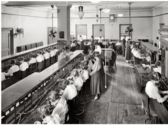
Figura 1 | Central telefônica da Chesapeake & Potomac Telephone Co., em Washington D.C., em 1919
