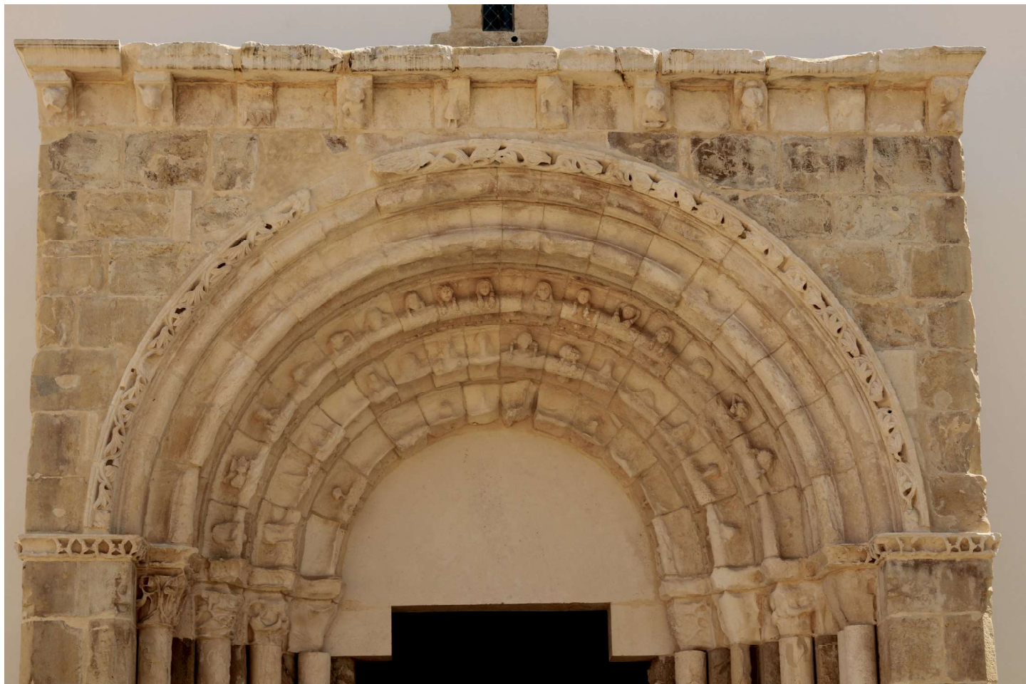
Alçado oeste. Portal
