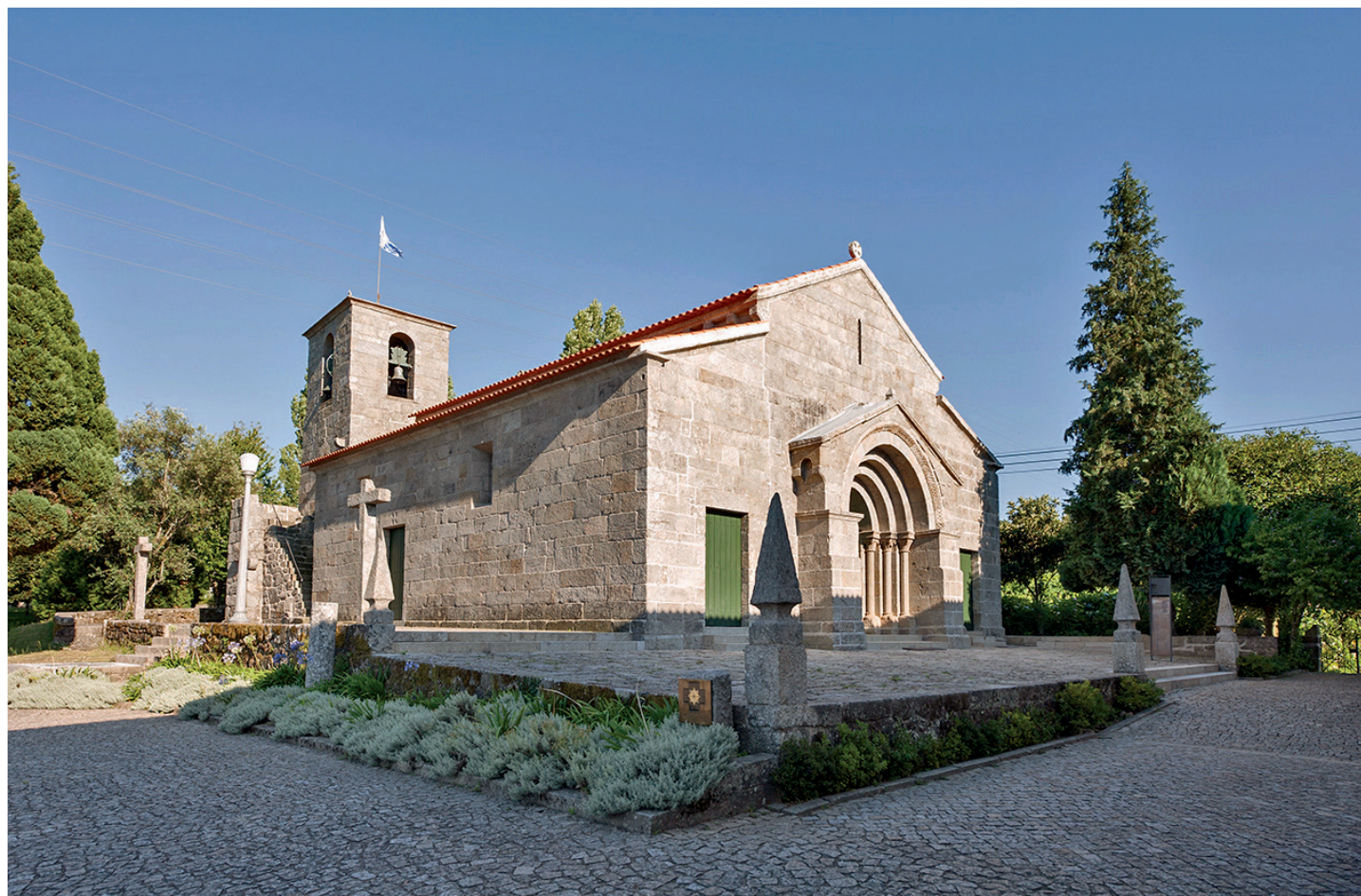
Perspetiva geral da igreja. Alçados oeste e norte
