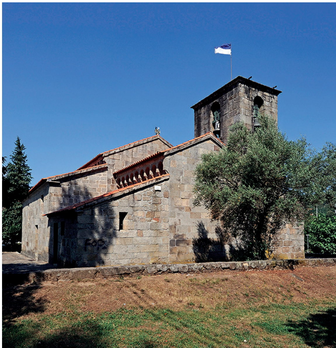
Perspetiva geral da igreja. Alçado este
