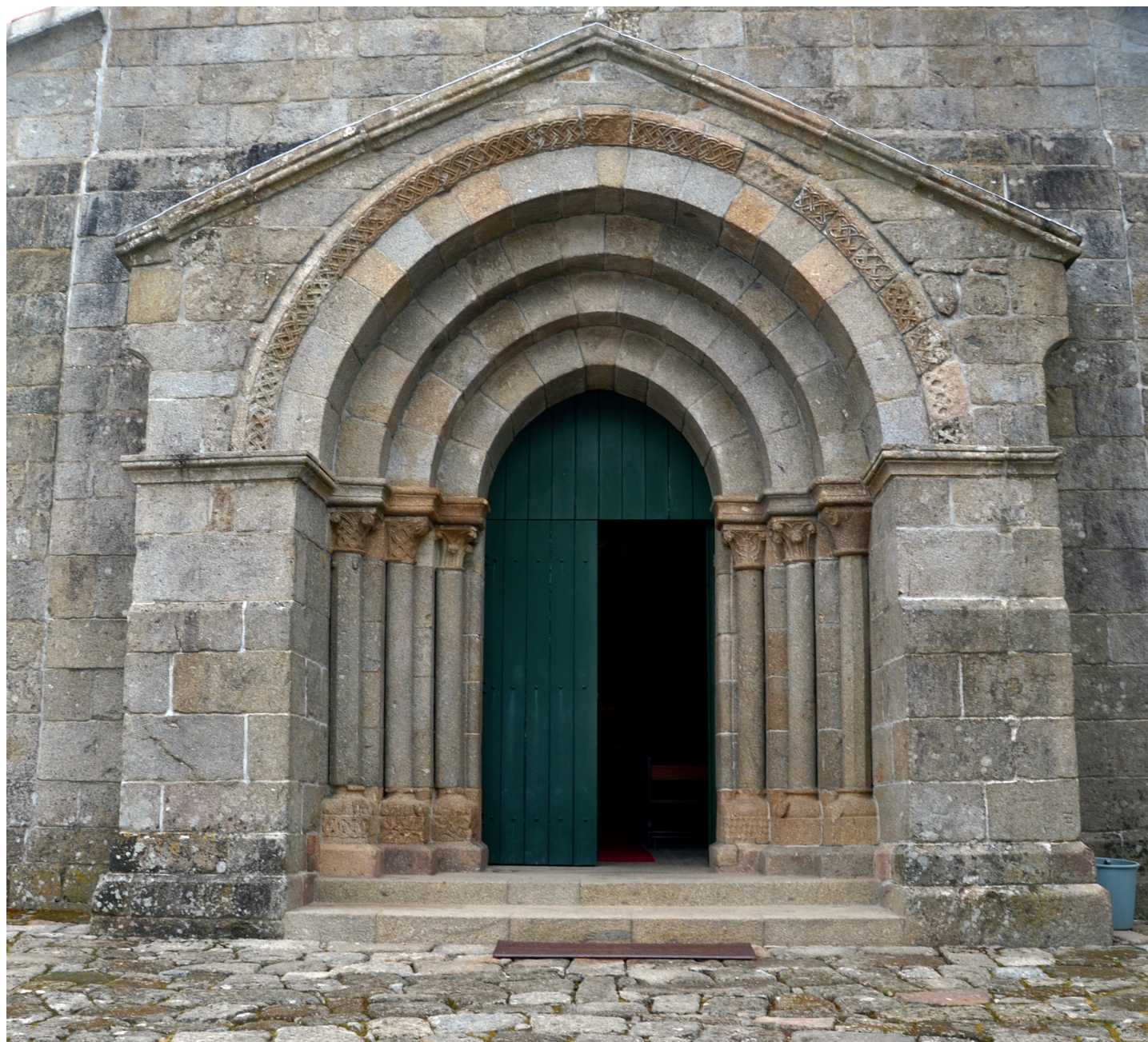
Alçado oeste. Portal
