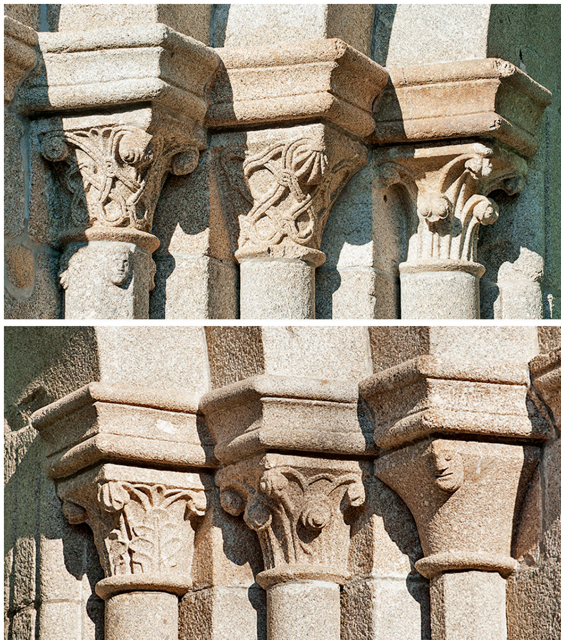
Pormenor dos capitéis do portal ocidental
