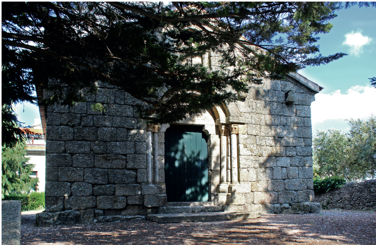
Perspetiva geral da igreja. Alçado oeste
