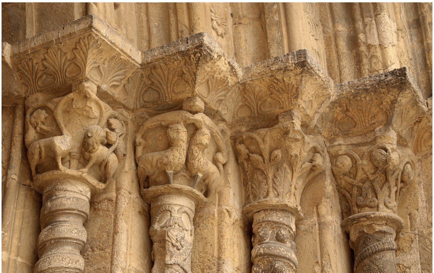
Portal oeste. Pormenor dos capitéis
