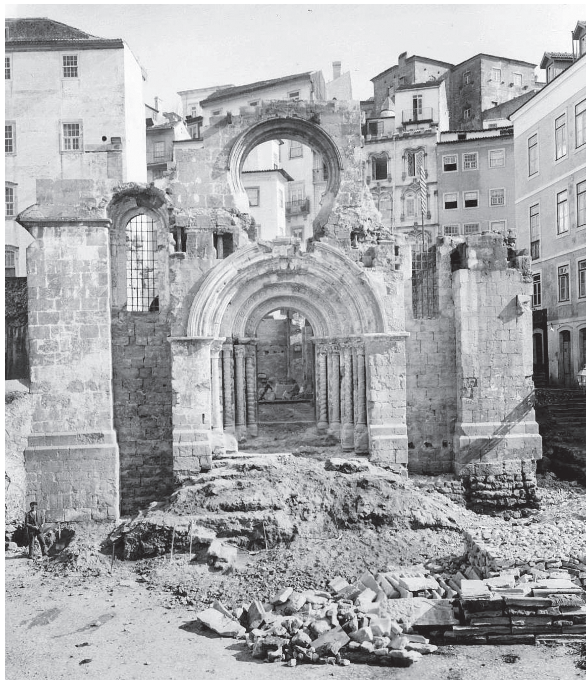
A igreja durante as obras de restauro. Alçado oeste (SIPA-DGPC)
