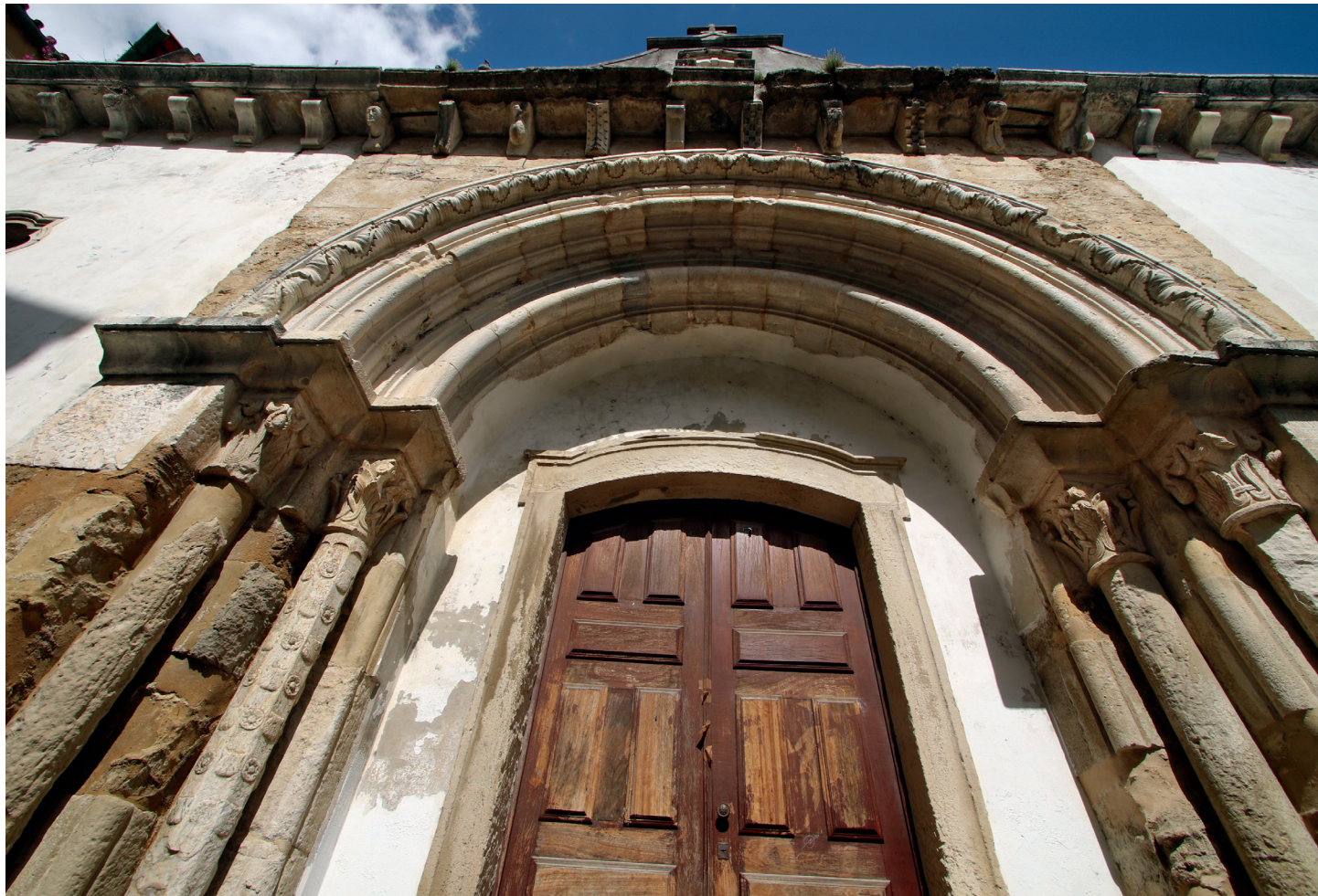
Alçado oeste. Portal
