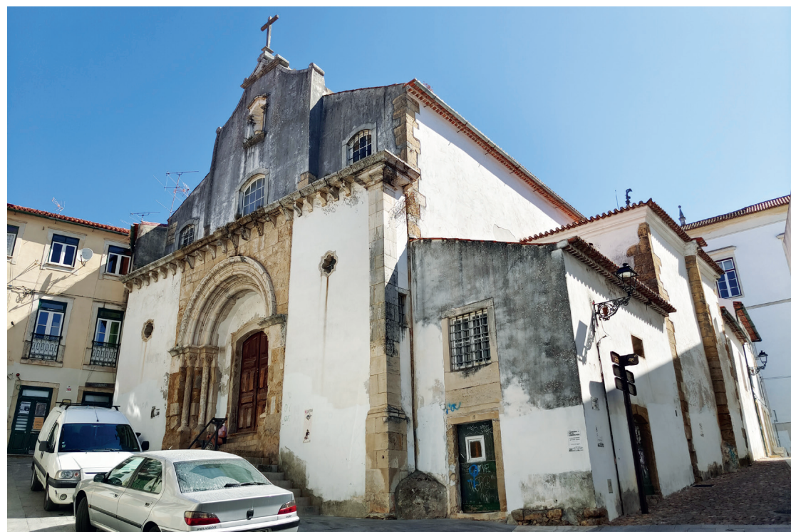
Perspetiva geral da igreja. Alçados oeste e sul
