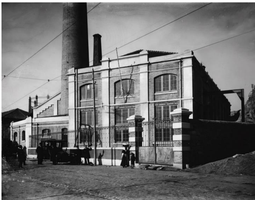
Figura 8 – Vista da fachada da Central Elétrica na Rua do Ouro
