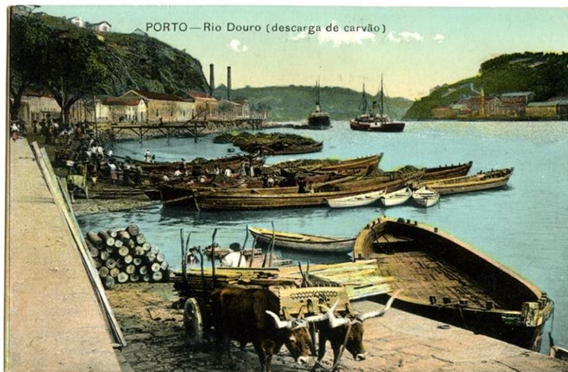
Figura 4 – Rio Douro (descarga de carvão)
