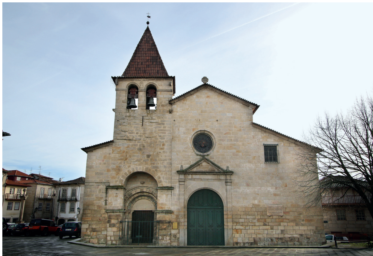
Perspetiva geral da igreja. Alçado oeste
