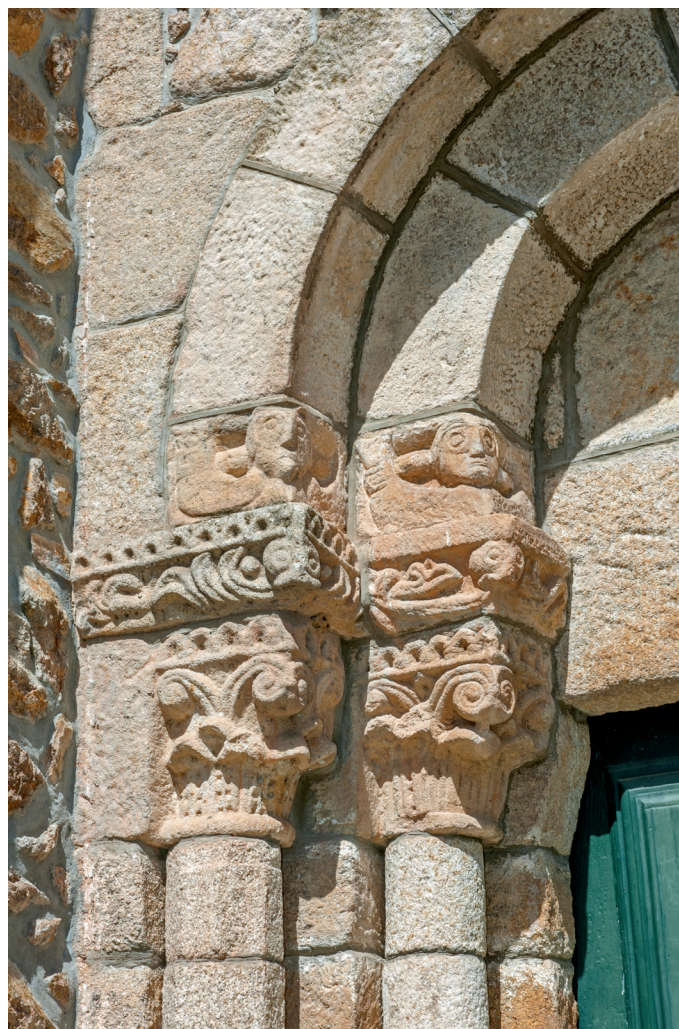
Portal norte. Pormenor
