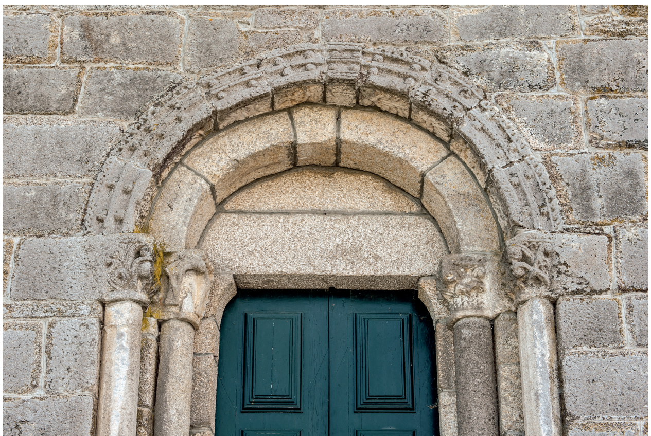
Portal sul. Pormenor
