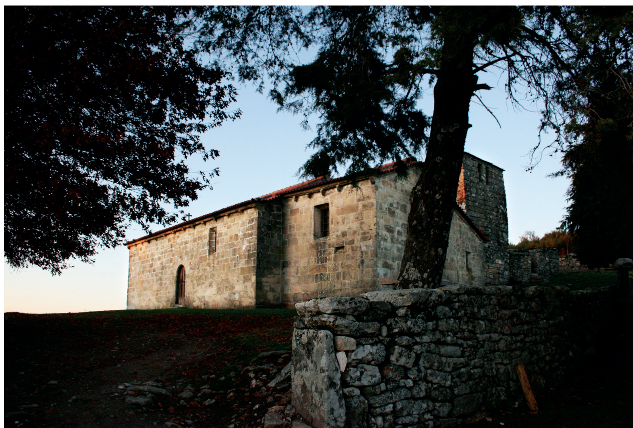
Perspetiva geral da igreja. Alçados este e sul e torre
