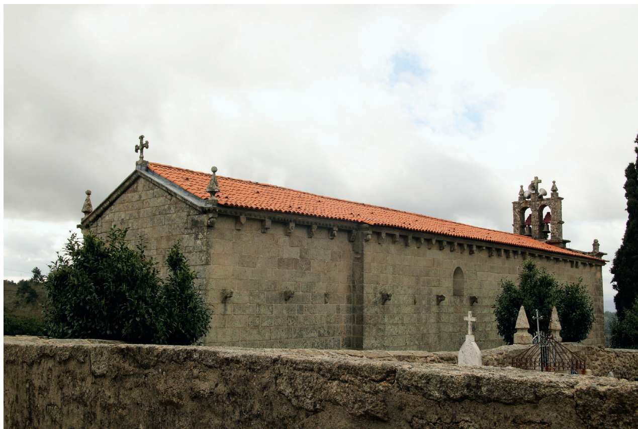
Perspetiva geral da igreja. Alçados este e norte
