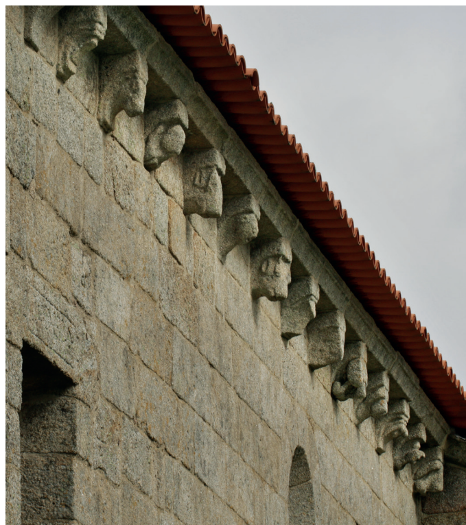
Cachorros do alçado sul da nave
