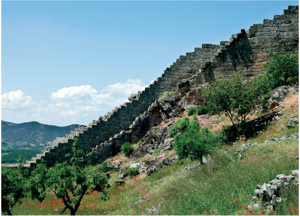
Muralha sudoeste: as mais longas escadas de acesso ao adarve de um castelo português
