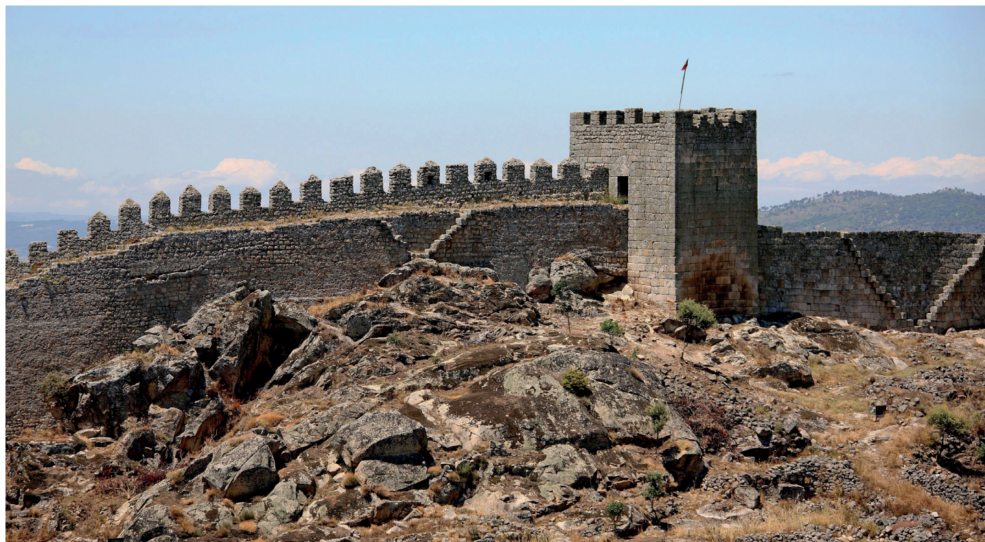
Torre do Cerco, a norte da Porta do Sol, e escadas de acesso ao adarve
