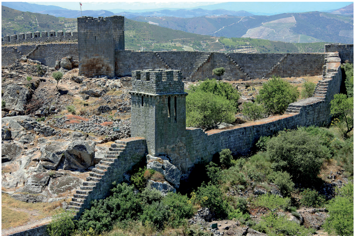
No primeiro plano o torreão a norte da Porta de São Pedro e, ao fundo, a Torre do Cerco (2008, Direção Regional de Cultura do Norte©, fotografia de Francisco Piqueiro - Foto Engenho - Projectos e Serviços de Fotografia, Lda.)
