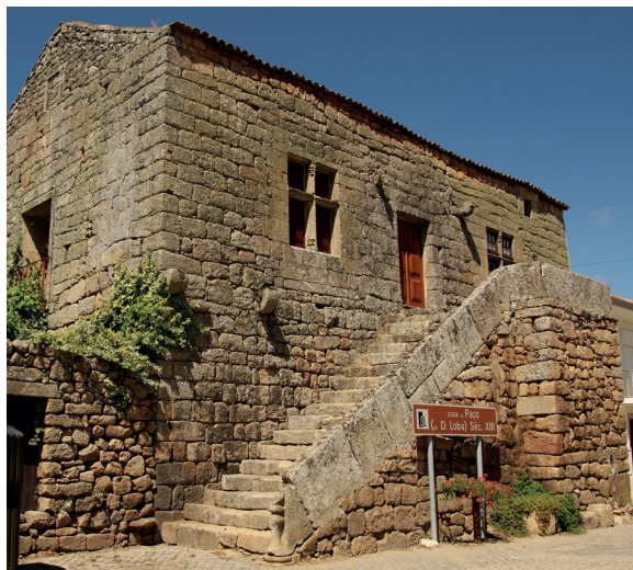
Vista geral da fachada principal
