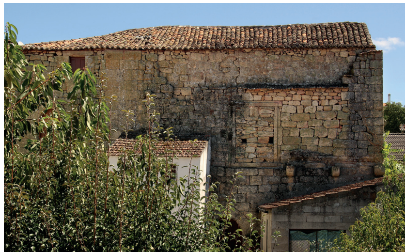
Vista geral da fachada anterior
