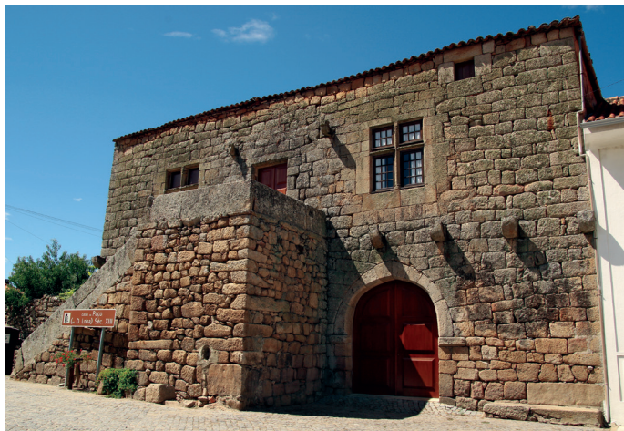
Vista geral da fachada principal
