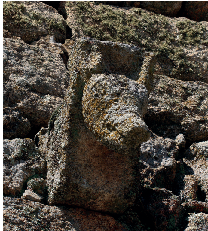
Cachorro ou modilhão da fachada principal
