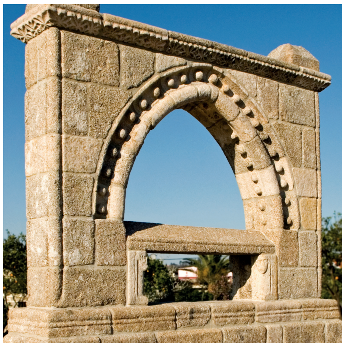
Pormenor do alçado sul
